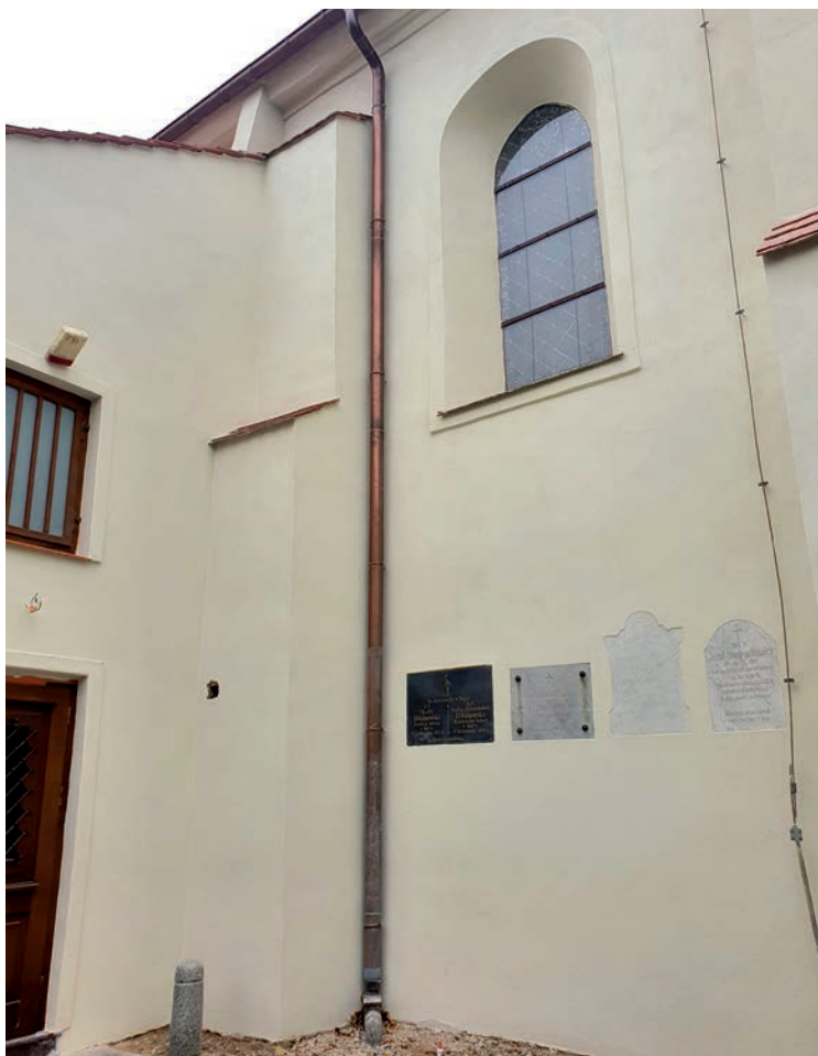
Elewacja po wykonanych pracach konserwatorskich
