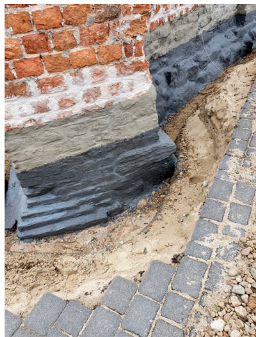
Etap wykonywania hydroizolacji pionowej na odsłoniętych partiach fundamentu
