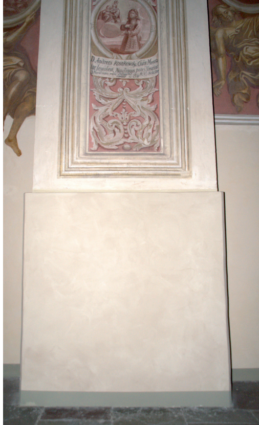
Fragment ściany z powłoką farby silikonowo- -wapiennej
