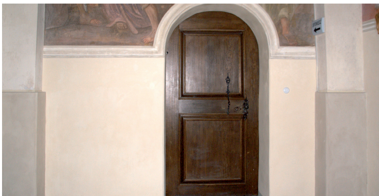
Fragment ściany po konserwacji z powłoką wapienną
