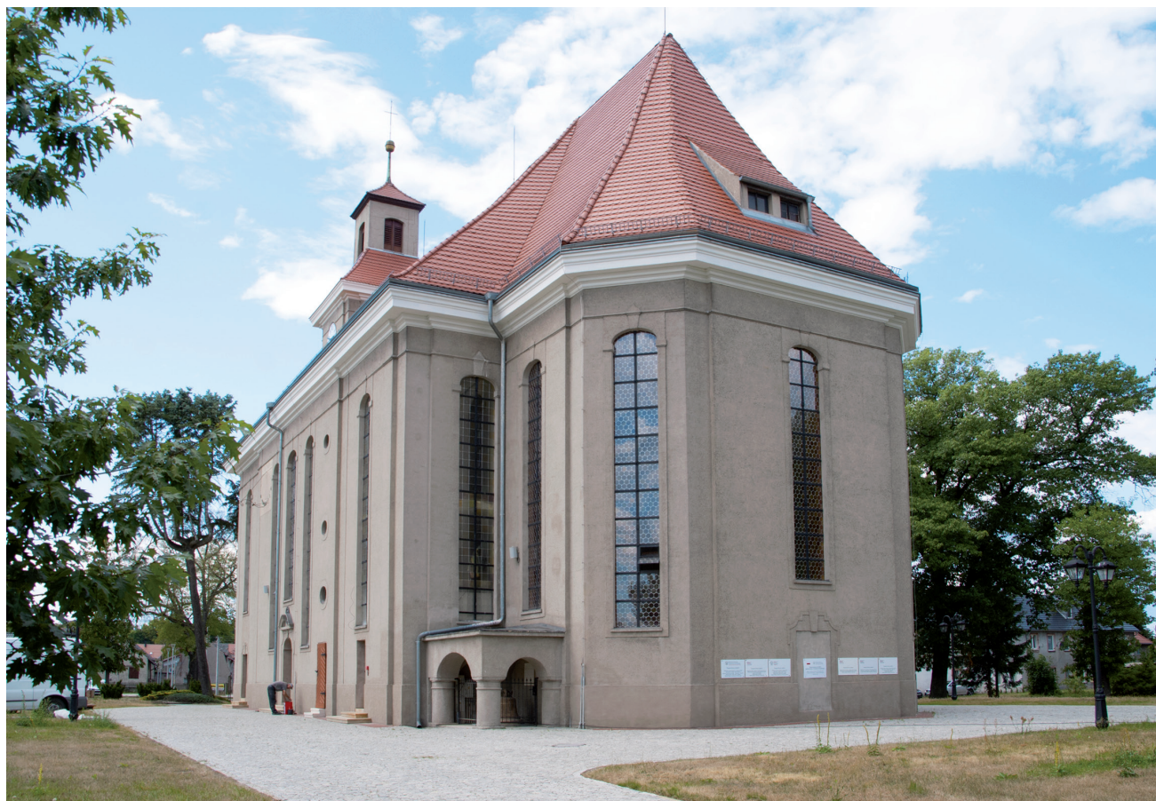
Fot. 6. Elewacja po zakończeniu prac
