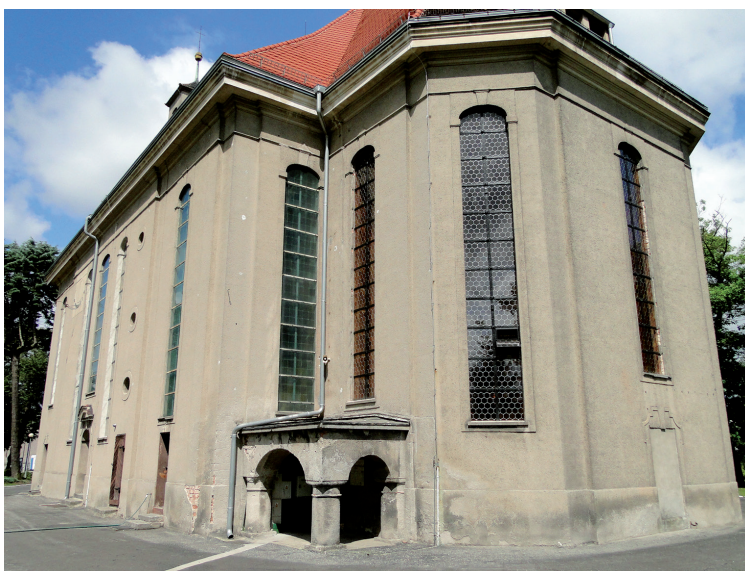
Fot. 2. Elewacja przed rozpoczęciem prac
