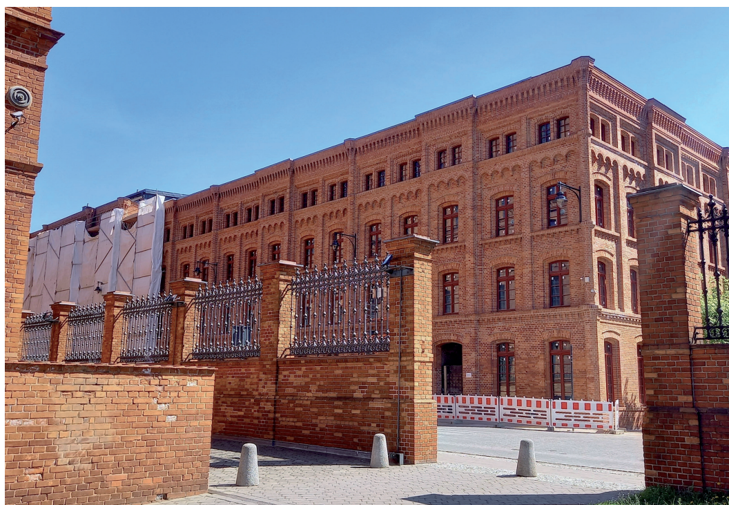
Famuły Poznańskie od strony ul. Ogrodowej w trakcie prac remontowych
