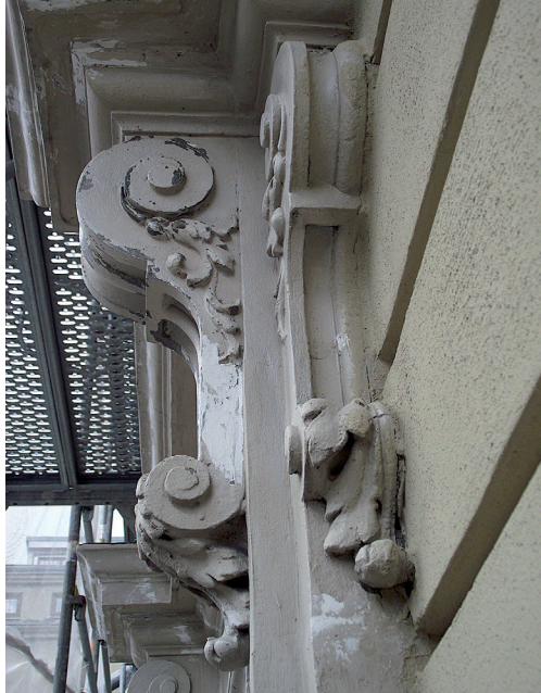
Przekrycie licznych rys elewacji specjalnym gruntem Optosan RissGrund
