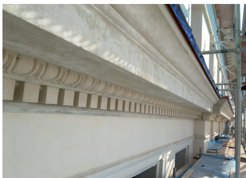
Wyprowadzone na nowo płaszczyzny gzymsu wieńczącego. Efekt finalny prac sztukatorskich, przed scaleniem kolorystycznym
