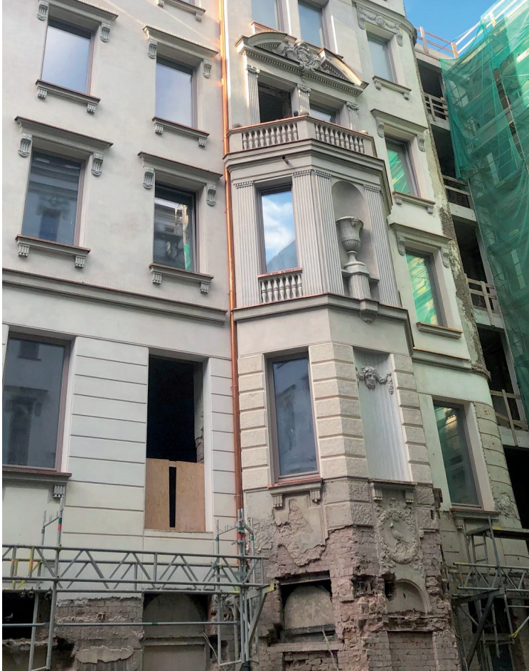
Fragment elewacji na dziedzińcu górna partia po unifikacji kolorystycznej. Partia parteru po usunięciu cementowego narzutu. Widoczne znaczne uszkodzenia struktury muru wynikające z przekształceń architektonicznych
