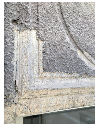
Usuwanie cementowego narzutu z elementów sztukatorskich
