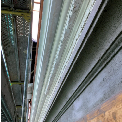
Proces uzupełnień brakujących fragmentów gzymsów
