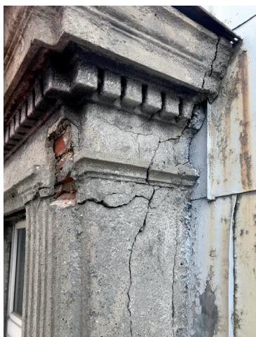
Dekoracja sztukatorska, detal. Widoczny stan zachowania przed konserwacją
