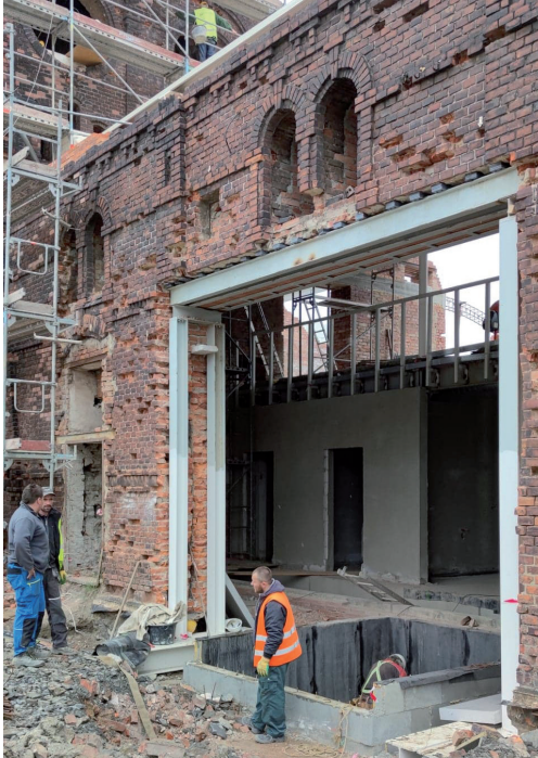
Budowa obrotowych ścian wymagała wzmocnienia po obwodzie ceglanych murów stalowymi ramami. Następnie wstawiono w nie konstrukcję ościeżnic z centralnie umieszczoną obracaną kolumną
