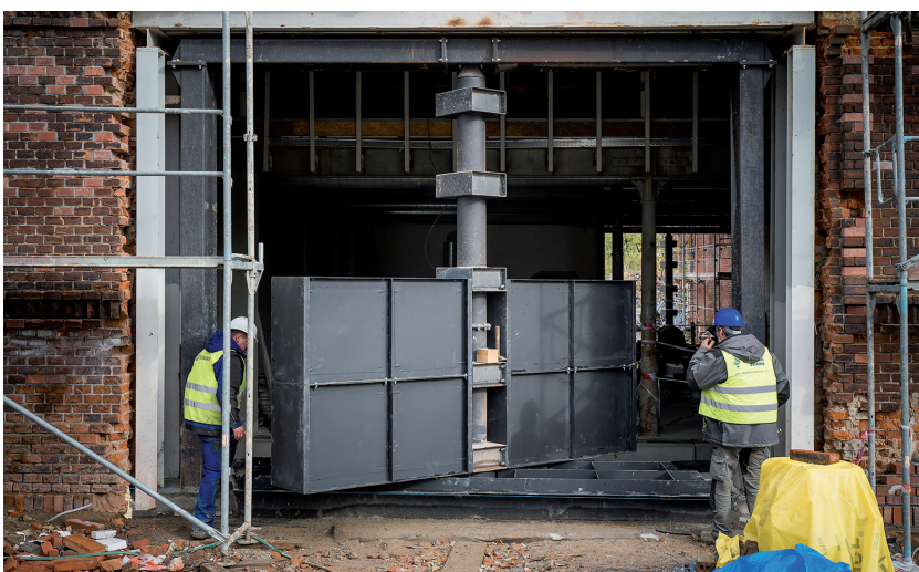
Budowa obrotowych ścian wymagała wzmocnienia po obwodzie ceglanych murów stalowymi ramami. Następnie wstawiono w nie konstrukcję ościeżnic z centralnie umieszczoną obracaną kolumną
