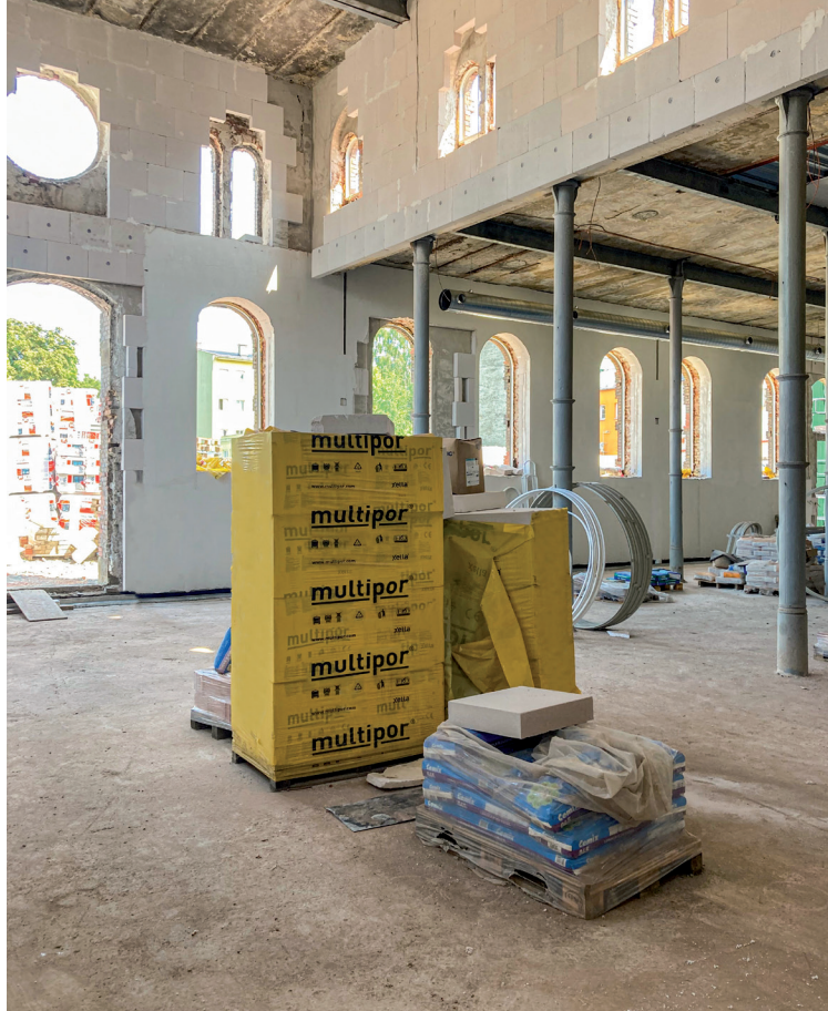
Montaż ocieplenia od środka w systemie Multipor. Dolne warstwy płyt, które nie mają oparcia, np. nad otworami lub we fragmentach ścian ponad kolumnami, wykonawca dodatkowo kołkował
