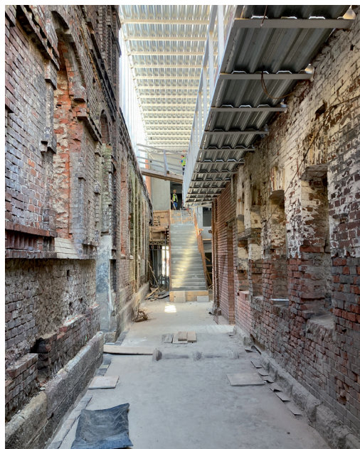
Po lewej: dawne podwórko, które po przebudowie zyskało zadaszenie, stało się centralnym holem galerii. Po prawej: montaż ocieplenia z płyt Multipor o grubości 125 mm
