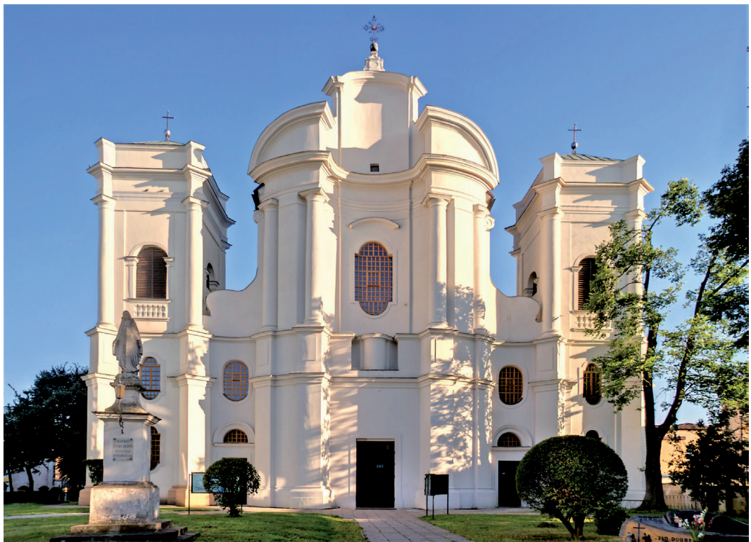
Kościół Ojców Pijarów w Łowiczu – wykorzystanie zapraw sztukatorskich Optosan w pracach renowacyjnych na elewacji
