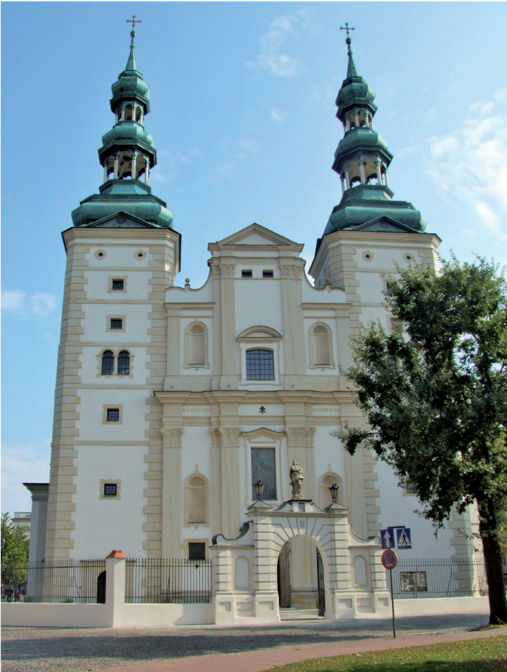
Bazylika w Łowiczu. Silnie spękane stare tynki po wzmocnieniu i oczyszczeniu zostały przykryte specjalnym tynkiem TrassFeinputz, zazbrojonym długimi mikrowłóknami
