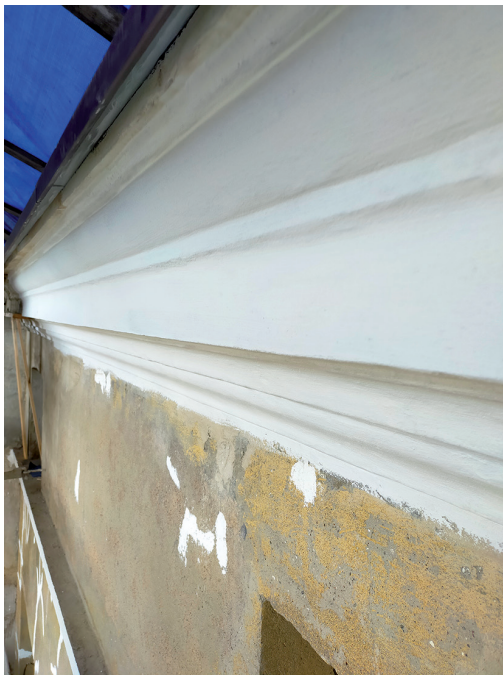
Reprofilacja – wyostrzenie rysunku gzymsu
