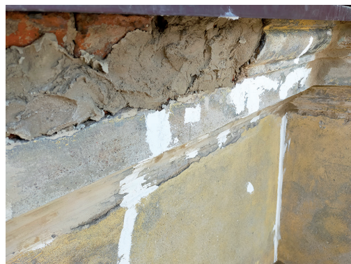
Gzyms w trakcie prac
