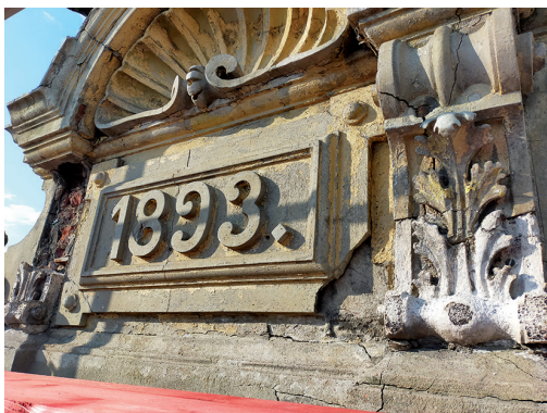
Szczyt z datą przed pracami
