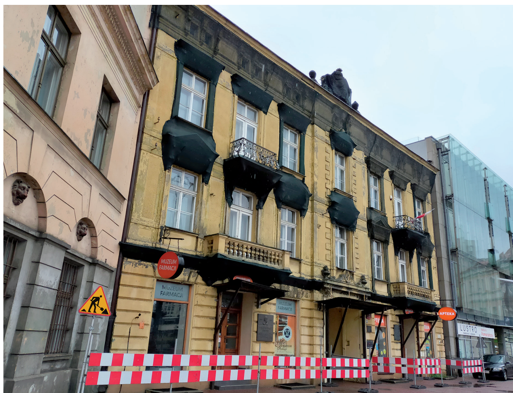
Łódź, plac Wolności 2 przed remontem
