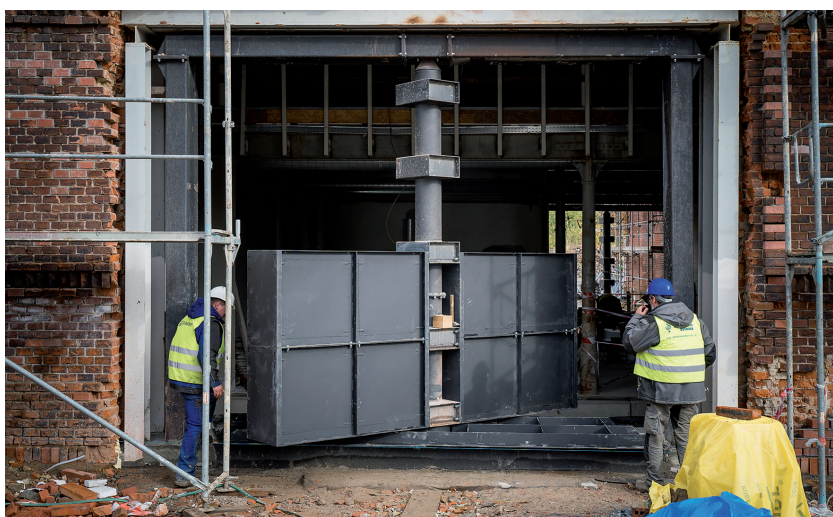
Budowa obrotowych ścian wymagała wzmocnienia po obwodzie ceglanych murów stalowymi ramami. Następnie wstawiono w nie konstrukcję ościeżnic z centralnie umieszczoną obracaną kolumną
