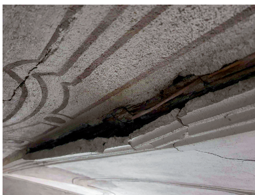
Odspojenia sztukaterii
