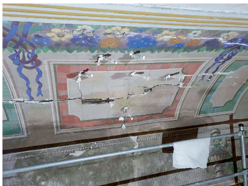
Faseta z nawy głównej w trakcie podklejania (fot. po lewej)
