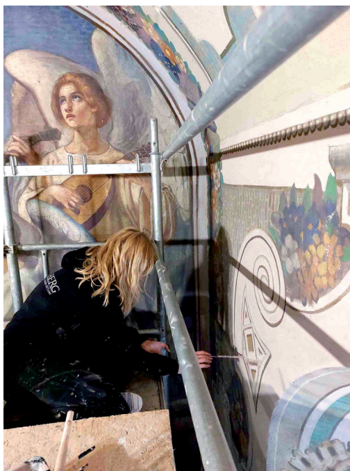
Punktowanie ubytków na ścianie nawy głównej
