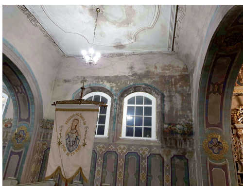
Ciemne plamy i wysolenia po zalaniu krużganków naw bocznych
