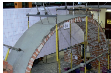
Rys. 3. Widok badanego łuku (wraz z czujnikami przemieszczeń) – łuk A2
