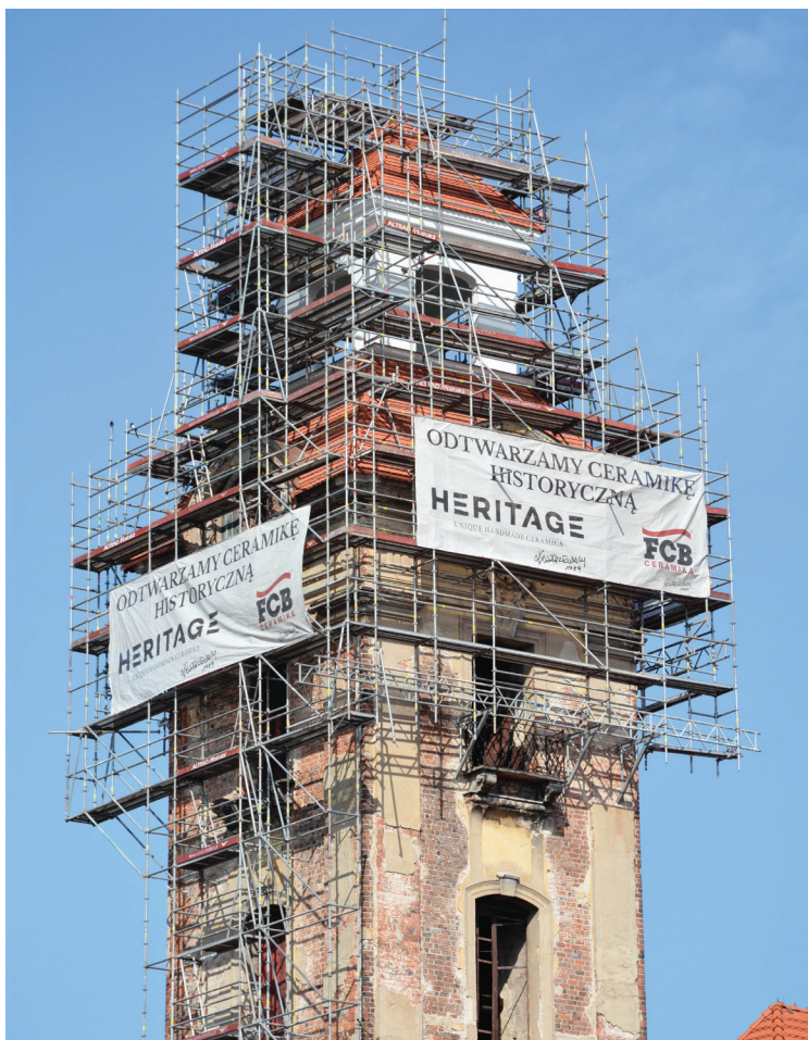
Żary, dachówka na hełmie wieży w trakcie montażu. Zwraca uwagę charakterystyczne kolorystyczne rozwibrowanie powierzchni dachu. Fot. Tomasz Nieruchalski – Heritage Roof Tiles Sp. z o.o., 2020
