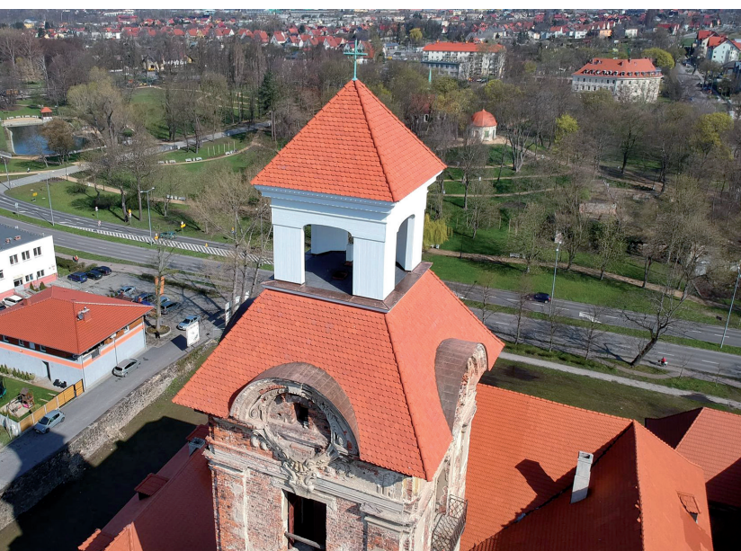
Żary, zrekonstruowany po pożarze barokowy hełm wieży pokryty dachówką karpiówką. Fot. Marcin Hładowski, 2020
