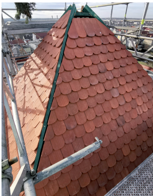
Żary, dachówka na hełmie wieży w trakcie montażu. Zwraca uwagę charakterystyczne kolorystyczne rozwibrowanie powierzchni dachu. Fot. Tomasz Nieruchalski – Heritage Roof Tiles Sp. z o.o., 2020
