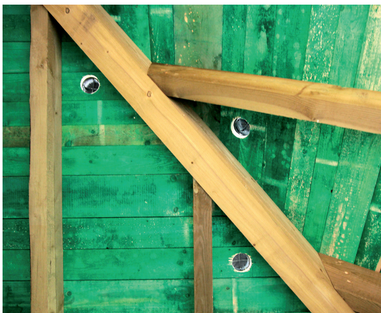
Vent'X-y zamontowane pod belkami grzbietowymi w dachu szalowanym i papowanym. Widok od środka
