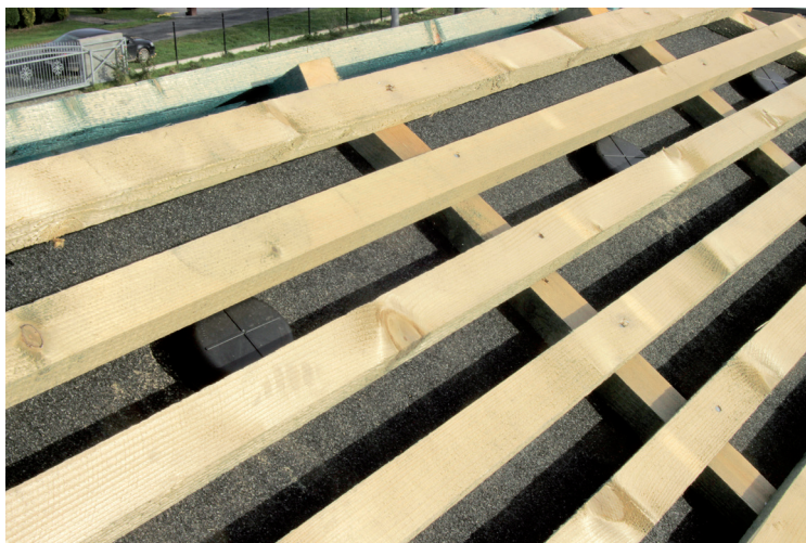
Vent'X na dachu szalowanym i pokrytym wstępnie papą Braas-BIT Premium SBS
