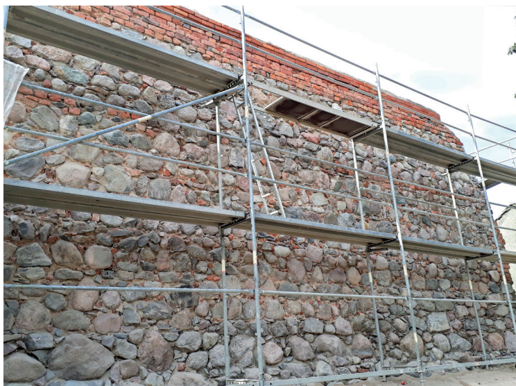
Mury w Myśliborzu – stan w trakcie prac – charakterystyczne, bardzo szerokie i głębokie spoiny wymagały użycia specjalnych zapraw aplikowanych mechanicznie
