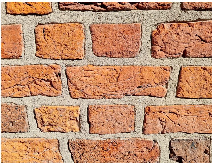
Różny sposób opracowania spoin zależnie od aplikacji i rodzaju wążku: TrassNaturstein Fuge NHL wprowadzona mechanicznie do nieregularnego, kamiennego wążku muru w Myśluborzu oraz TrassFuge zakładana ręcznie z podcięciem na ceglanych elewacjach Bramy Wałowej w Stargardzie (dolna fotografia)
