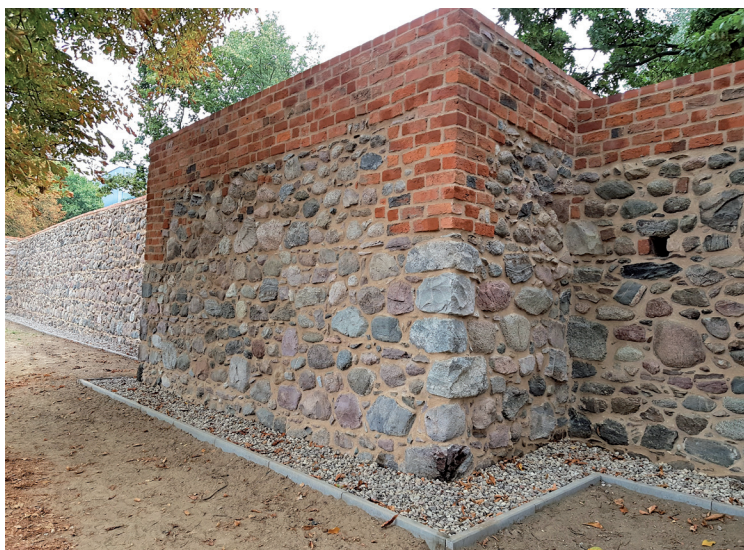
Myślibórz – fragment kamienno-ceglanych murów obronnych po renowacji
