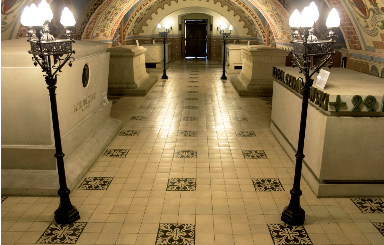
Krypta Zasłużonych na Skalce – posadzka uzupełniana podobnymi płytkami
