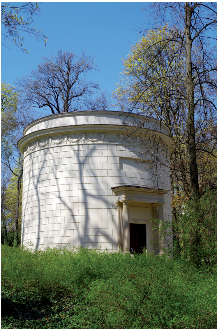
Fot. 3. Wodozbiór po renowacji
