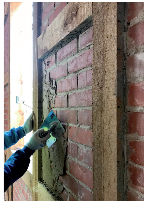
Wypełnienie tynkiem podkładowym na bazie gliny
