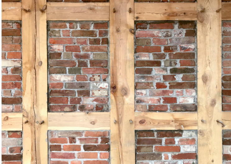
Drewniana konstrukcja wypełniona ceglami
