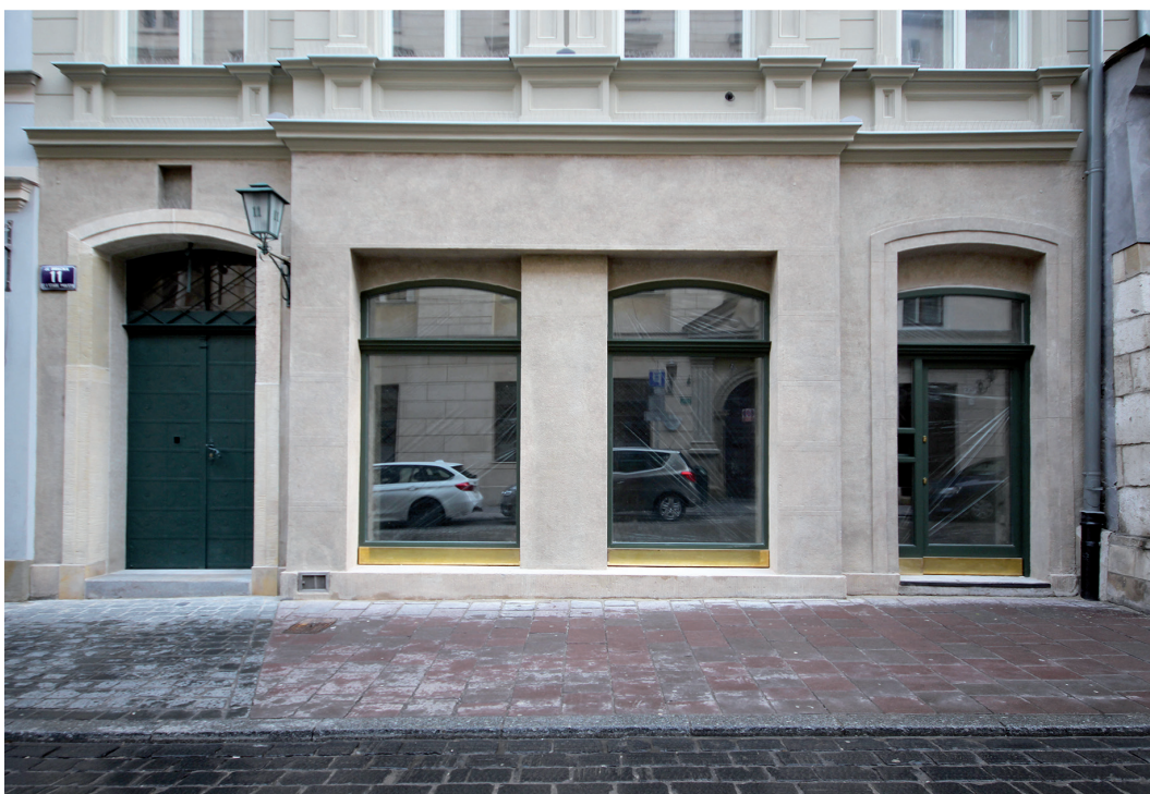
Elewacja frontowa kamienicy przy ul. Brackiej 11 w Krakowie, wykonana w tynku kamieniarskim, stan po konserwacji. Fot. K. Feć-Sfora, Archiwum Art Forum Bożena Boba-Dyga
