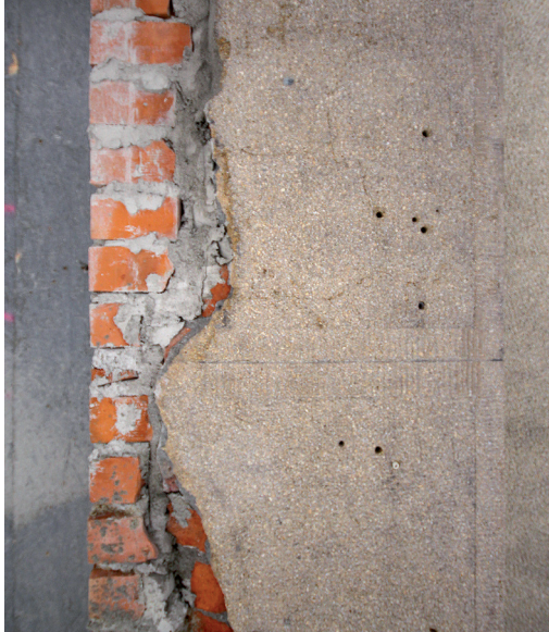
Elewacja frontowa kamienicy przy ul. Brackiej 11 w Krakowie, wykonana w tynku kamieniarskim, widoczne ubytki tynku kamieniarskiego. Fot. K. Feć-Sfora, Archiwum Art Forum Bożena Boba-Dyga
