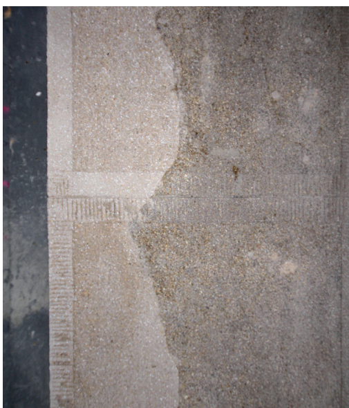
Elewacja frontowa kamienicy przy ul. Brackiej 11 w Krakowie, wykonana w tynku kamieniarskim, widoczne ubytki tynku kamieniarskiego. Fot. K. Feć-Sfora, Archiwum Art Forum Bożena Boba-Dyga
