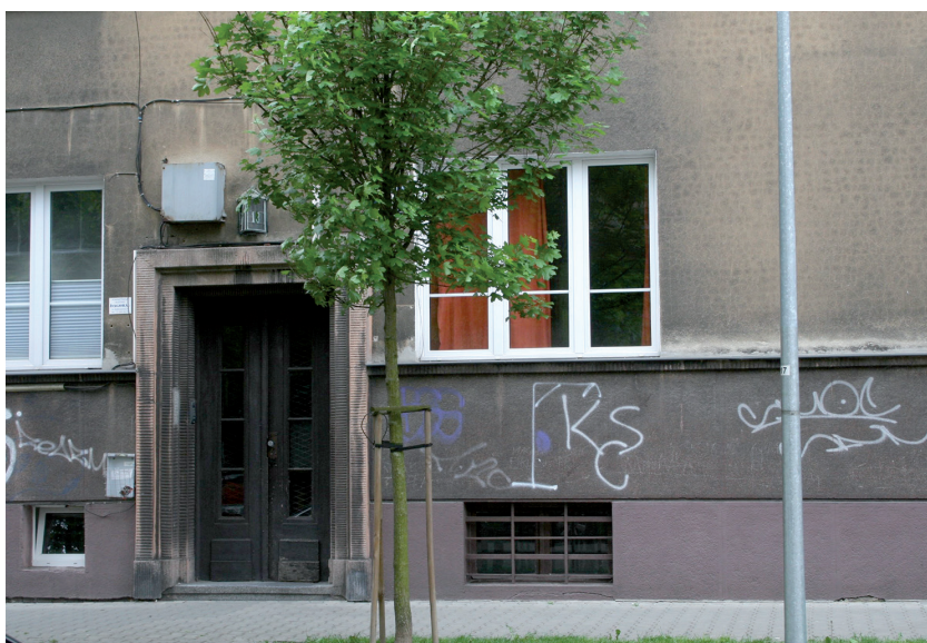
Graffiti na cokole z tynku szlachetnego do usunięcia metodami specjalistycznymi, dolna partia cokołu pomalowana farbą zmieniającą fakturę tynku.
