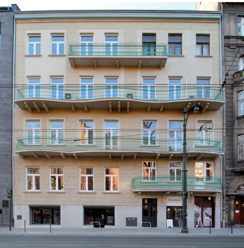
Elewacja frontowa kamienicy przy ul. Straszewskiego 24 w Krakowie, wykonana w tynku szlachetnym z miką i łyszczkiem oraz tynku kamieniarskim, stan po konserwacji. Fot. K. Feć-Sfora, Archiwum Art Forum Bożena Boba-Dyga
