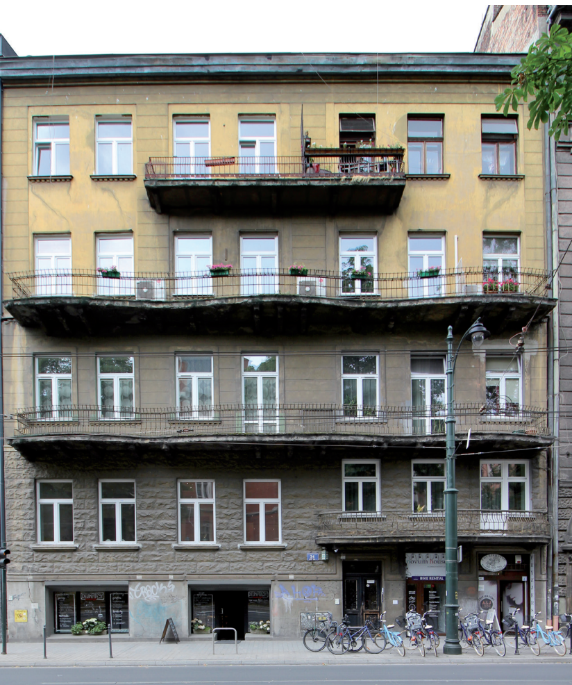
Elewacja frontowa kamienicy przy ul. Straszewskiego 24 w Krakowie, wykonana w tynku szlachetnym z miką i łyszczkiem oraz tynku kamieniarskim, stan po konserwacji. Fot. K. Feć-Sfora, Archiwum Art Forum Bożena Boba-Dyga
