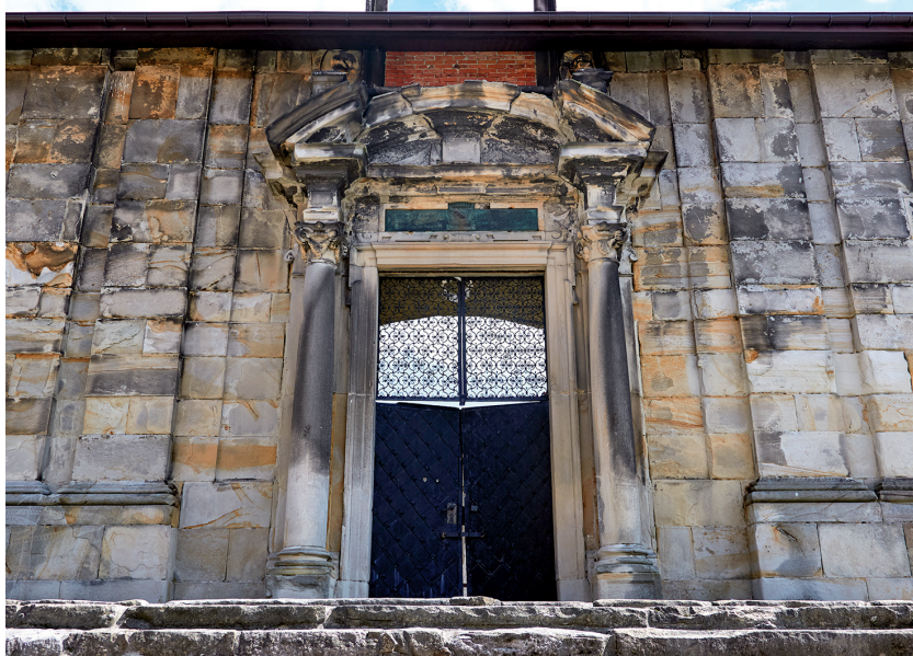
Wygląd elewacji frontowej – stan przed pracami konserwatorskimi
