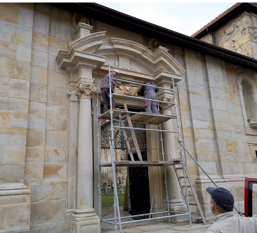
Montaż miedzianej inskrypcji w portalu wejściowym
