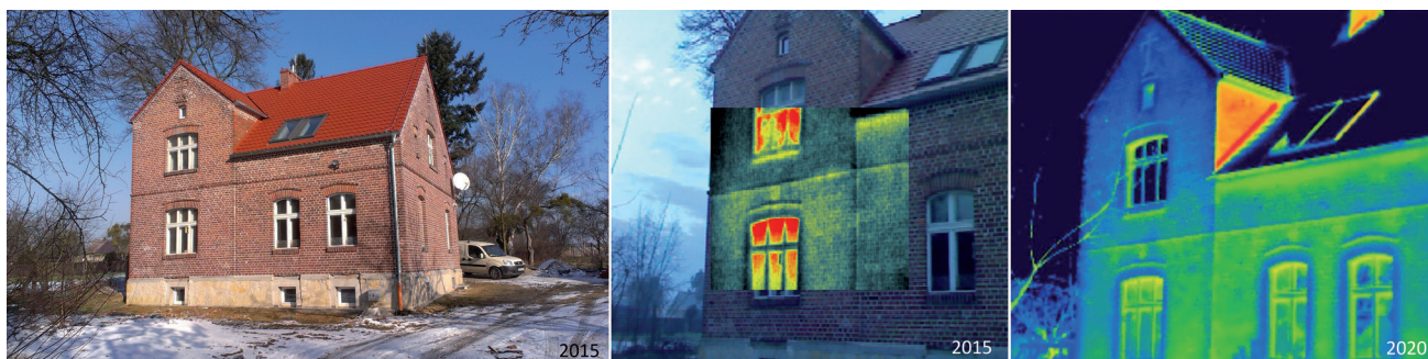
Rys. 1. Elewacja południowa 90-letniego budynku mieszkalnego: a) widok, b) zdjęcie termowizyjne 2015 r. c) zdjęcie termowizyjne 2020 r.
