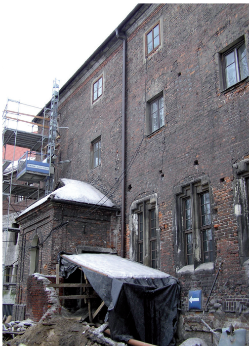
Zamek Królewski na Wawelu – budynek nr 7. Elewacja frontowa (płd.) – dom C. Stan przed konserwacją (fot. po lewej, luty 2006) i po konserwacji (fot. po prawej, sierpień 2009). Fot. B. Opiłło
