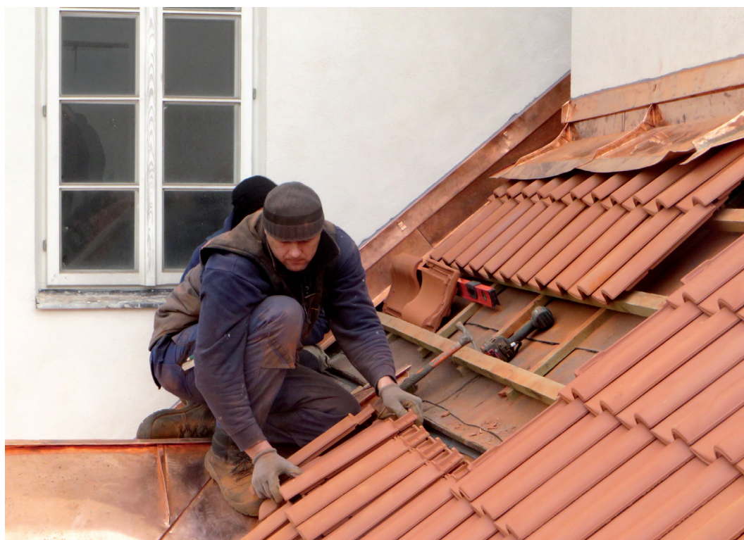
Dachówka Achat BMI Braas. Prace przy lukarnie
