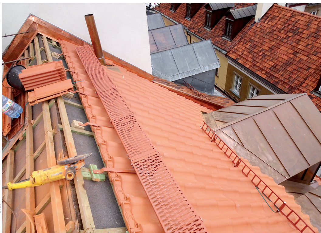
Dachówka Achat BMI Braas. Montaż komunikacji dachowej
