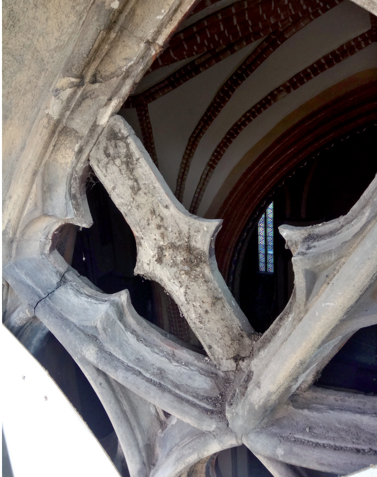
Fot. 5. Maswerk okienny, rekonstrukcja ubytków zaprawą Remmers Multi Fill [basic]
