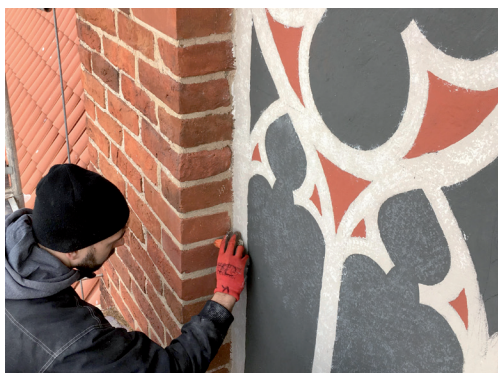
Prace nad opracowaniem kolorystycznym. Dzięki nanoszeniu kolejnych warstw o zróżnicowanych odcieniach uzyskano niejednorodną fakturę koloru
