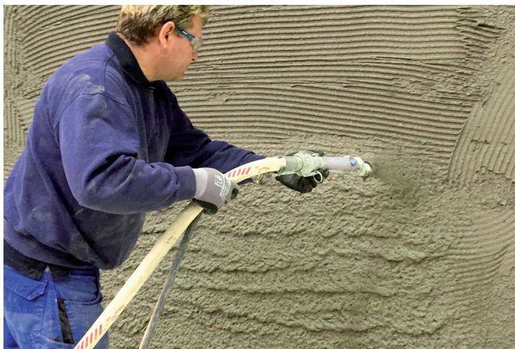
Fot. 3. Aplikacja maszynowa tynków SP Top White WTA
