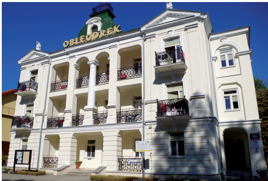
Fot. 4. Elewacja po zakończeniu prac
