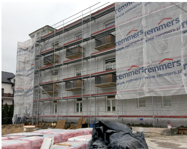
Fot. 2. Elewacja tylna po nałożeniu tynków SP Top White WTA
