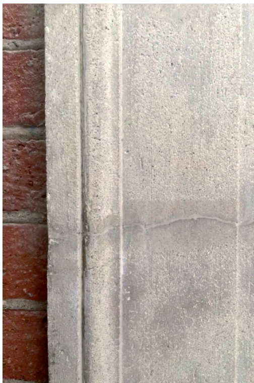
Fot. 4. Uzupełnianie ubytków detalu sztukatorskiego zaprawą Remmers Fill RZ Historic
