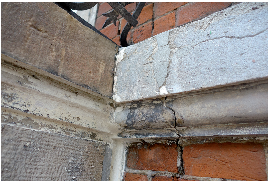
Fot. 3. Elementy dekoracji wykonane z piaskowca, cementu naturalnego i wążek ceglany w trakcie konserwacji
