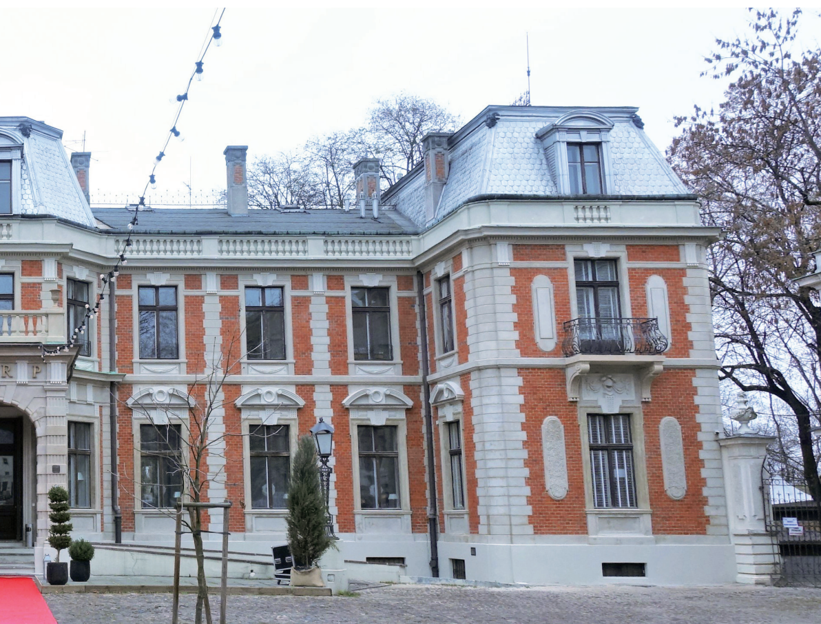
Fot. 5. Elewacja frontowa pałacu po zakończeniu prac konserwatorskich
