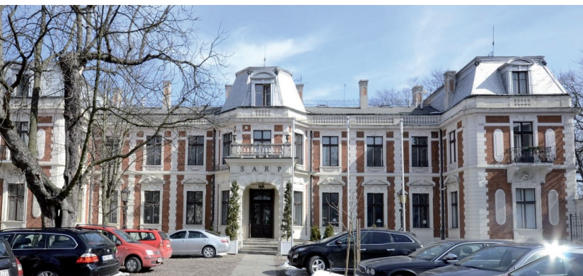
Fot. 1. Elewacja frontowa Pałacu Zamoyskich przed konserwacją
