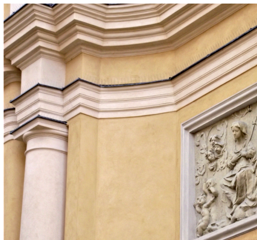
Tynk barwiony w masie – widoczne charakterystyczne „chmurki” powstałe podczas zacierania tynku na mokro
