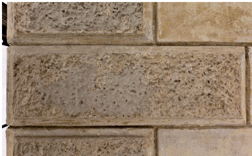
Fragment po usunięciu współczesnych nawarstwień z powierzchni zabytkowych tynków
