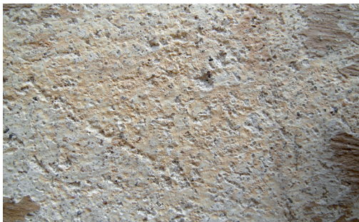
Fragment wyprawy tynkarskiej po oczyszczeniu z nawarstwień
