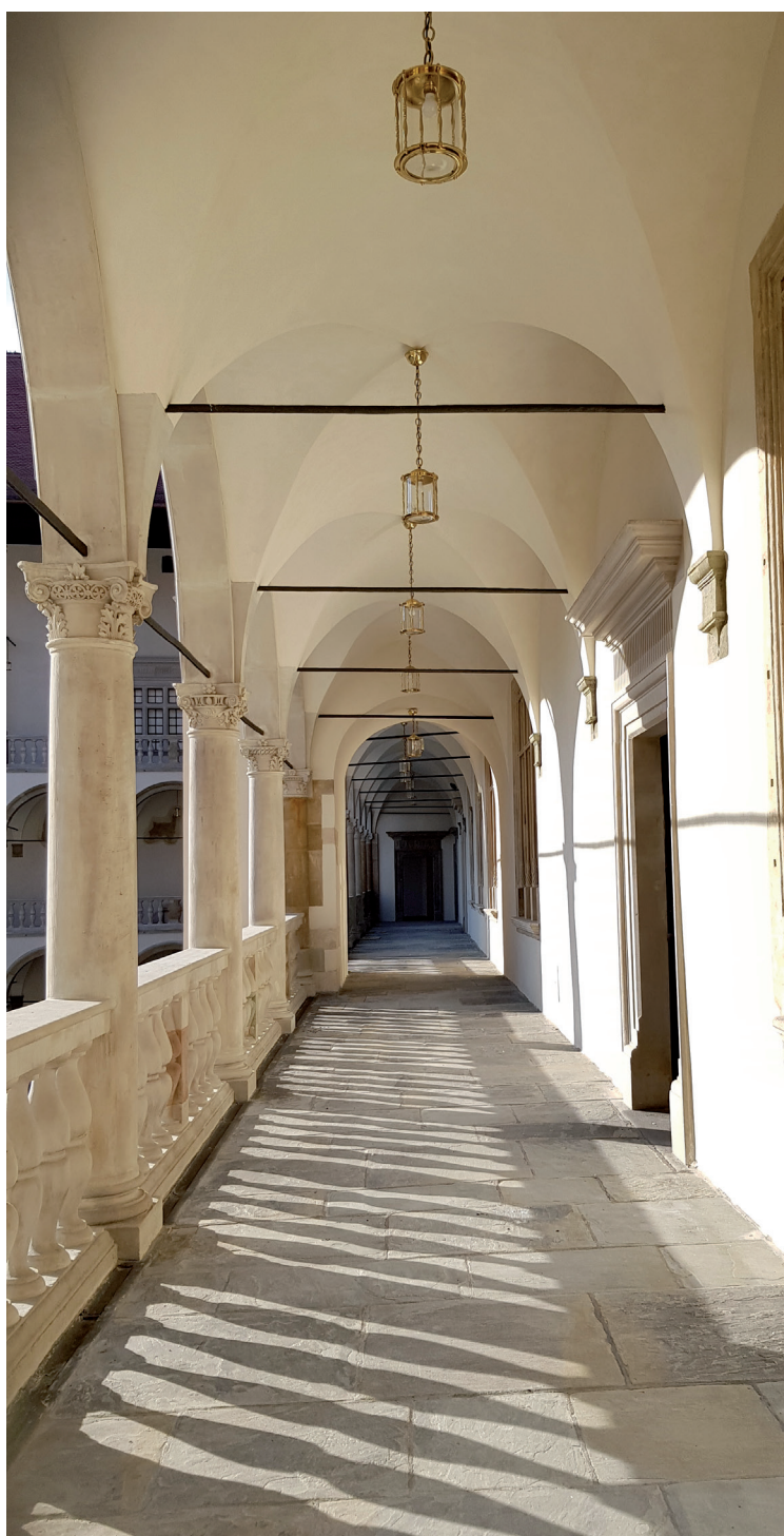
Skrzydło północne po zakończeniu prac, październik 2019
