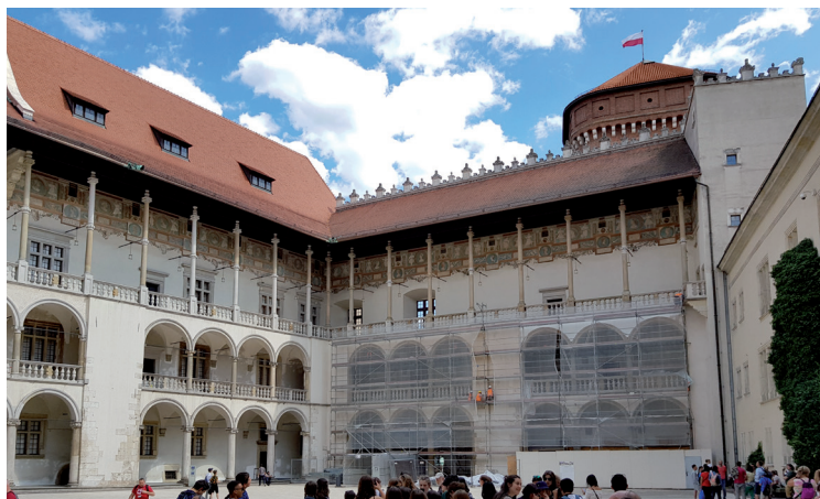
Skrzydło południowe w trakcie prac, lipiec 2019
