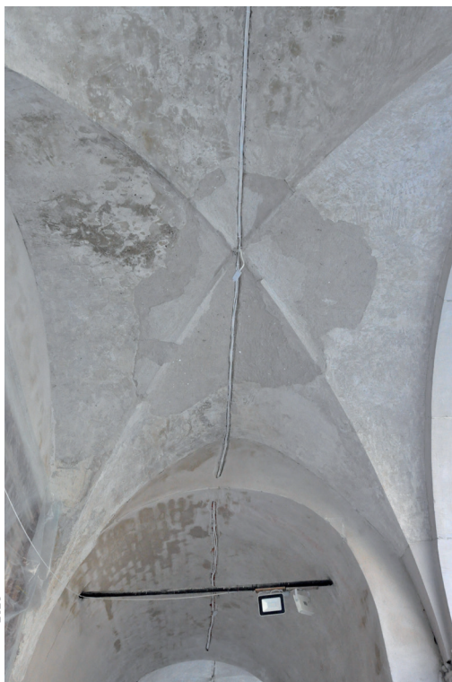
Skrzydło wschodnie, sklepienie w trakcie prac, styczeń 2019
