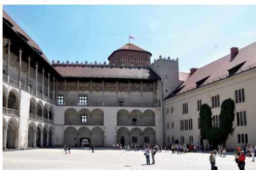
Skrzydło południowe przed rozpoczęciem prac, październik 2017
