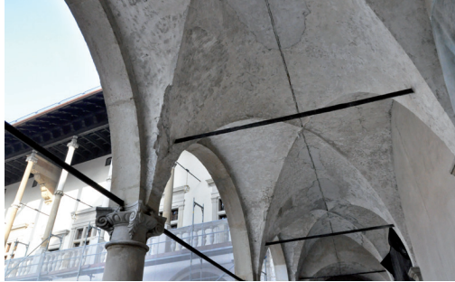
Skrzydło południowe, sklepienie w trakcie prac, styczeń 2019
