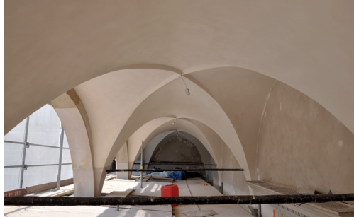
Skrzydło zachodnie, I piętro w trakcie prac, kwiecień 2019
