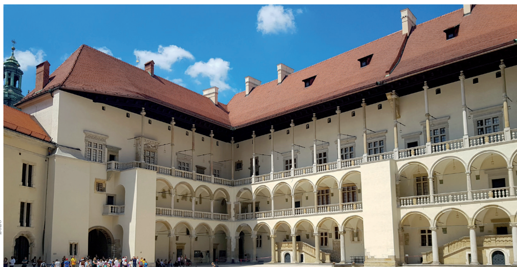
Skrzydło zachodnie po zakończeniu prac, czerwiec 2019
