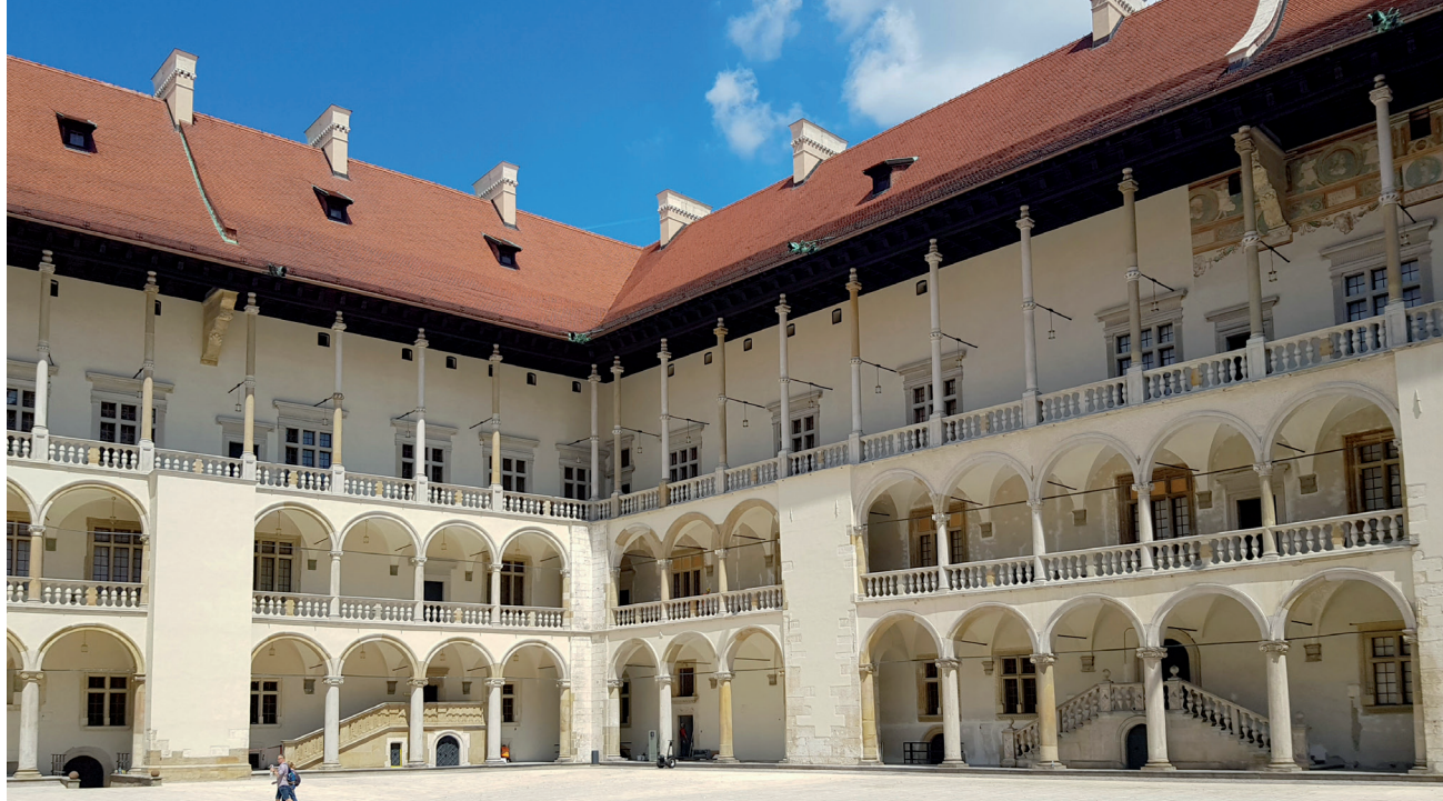
Narożnik północno-wschodni, widok elewacji przed i w trakcie prac (porównanie), czerwiec 2019
