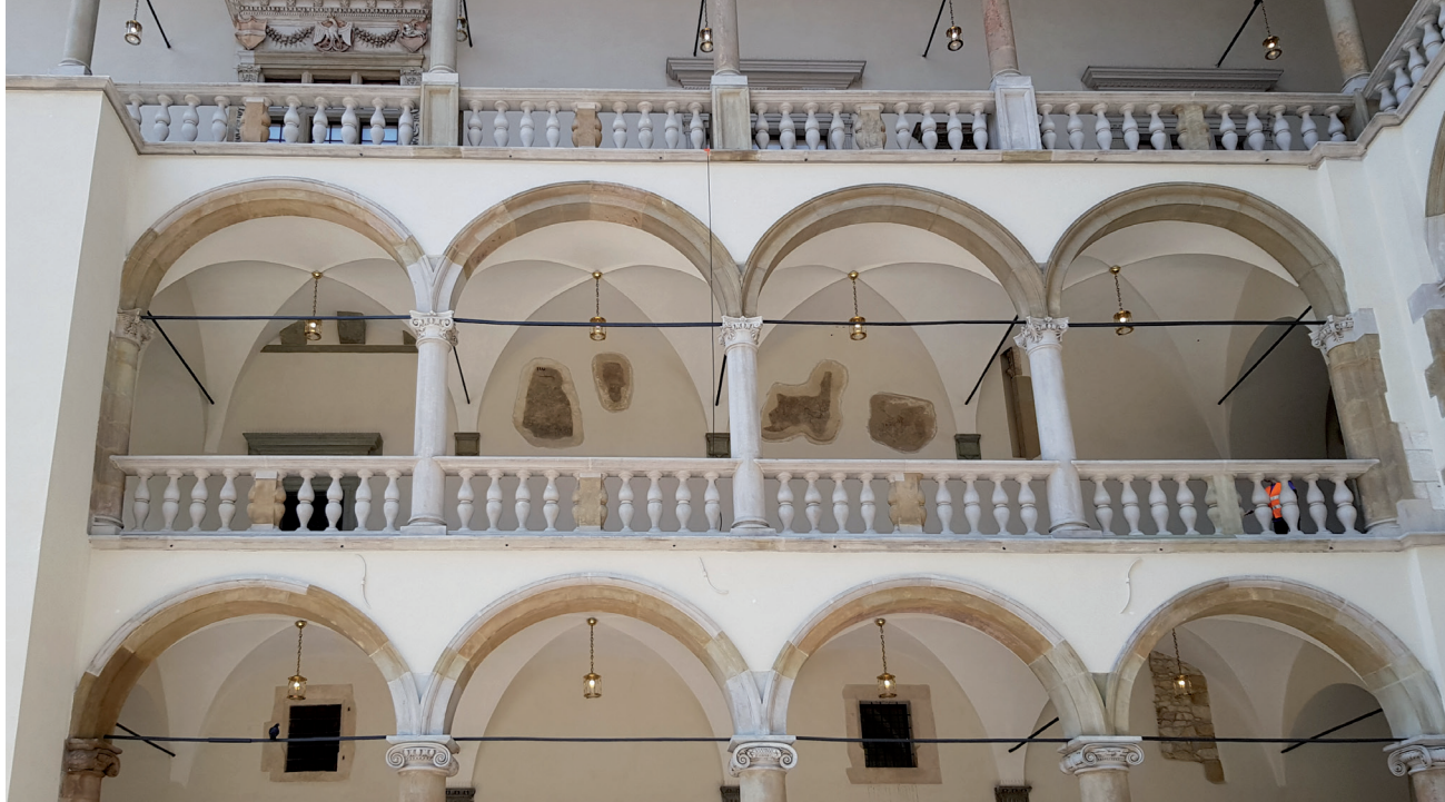
Skrzydło zachodnie po zakończeniu prac, sierpień 2019
