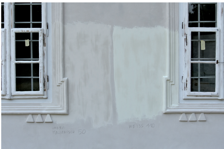
Fot. 3. Dwór w Modnicy w trakcie próbnych wymalowań (sierpień 2019)
