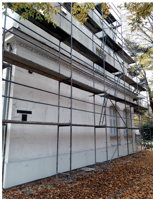
Fot. 1. Dworek przy ul. Powroźniczej – nieznaczne uszkodzenia tynku
