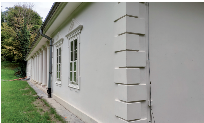
Fot. 5. Dwór po wymalowaniu Histolith Fassadenkalk (wrzesień 2019)
