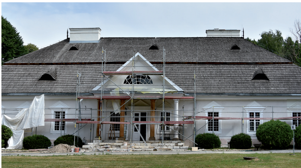
Fot. 4. Dwór w Modnicy w trakcie renowacji
