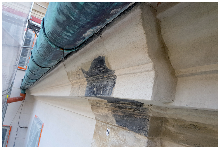
Elewacje Dziedzińca Wewnętrznego, stan w trakcie konserwacji. Widoczny świadek dekoracji malarskich imitujących wapien dębny oraz sonda schodkowa z badań stratygraficznych na gzymsie
