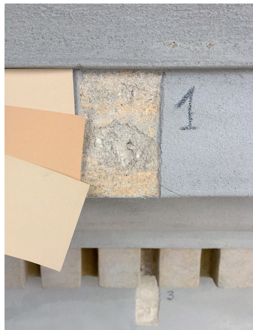
Dobieranie kolorystyki do odkrywek w badaniach stratygraficznych, praca nad stworzeniem mieszanki barwnej
