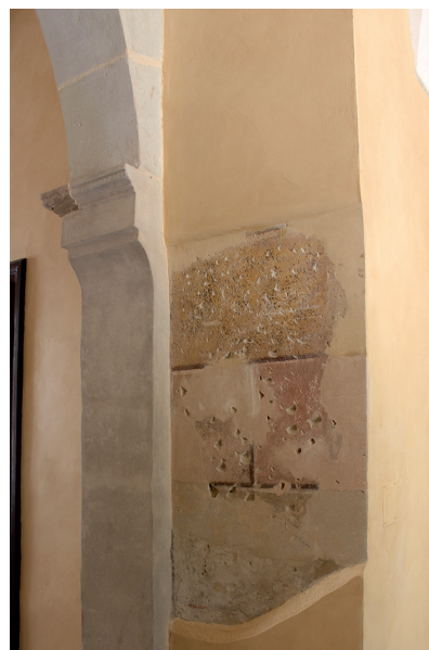
Dziedziniec Wewnętrzny, stan w trakcie konserwacji. Widoczne trzy fazy prac
