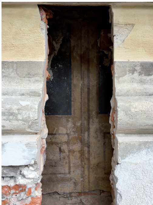
Znalezisko powstałe przy wykonywaniu kanałów wentylacyjnych – odkrycie zachowanych fragmentów neogotyckiej polichromowanej iluzjonistycznie elewacji zewnętrznej po stronie północnej
