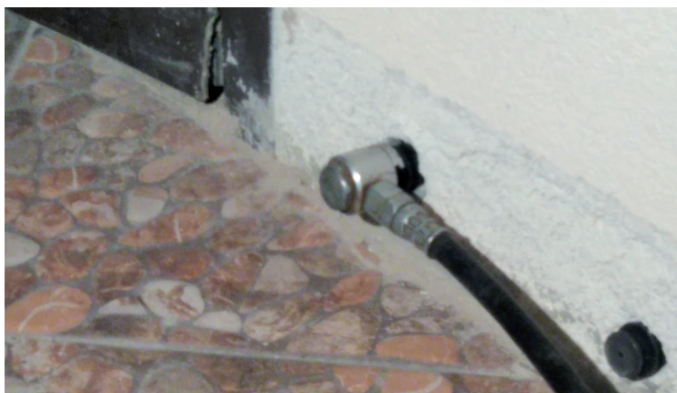
Aplikowanie środka w systemie niskociśnieniowym.
