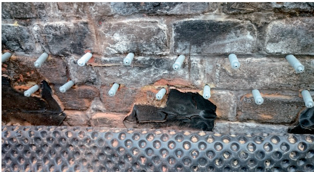
Otwory przygotowane do iniekcji dwurzędowej.
