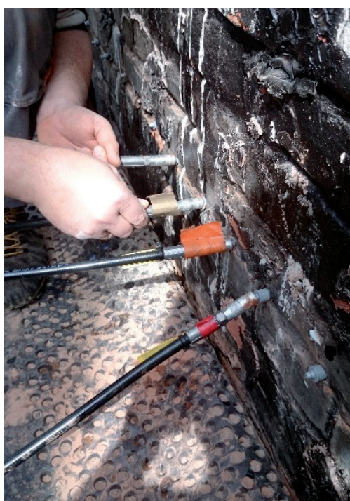
Prace przygotowawcze do aplikowania preparatu za pomocą agregatów.
