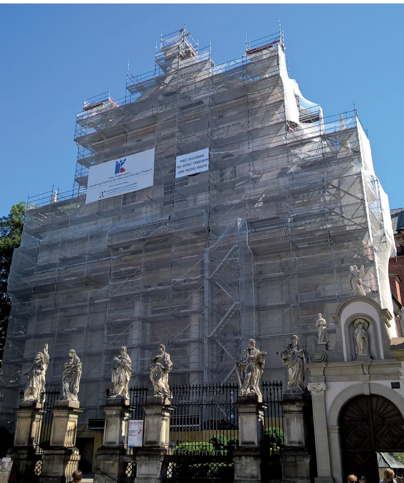
Fot. 1. Elewacja kościoła podczas prac konserwatorskich w 2016 roku.
