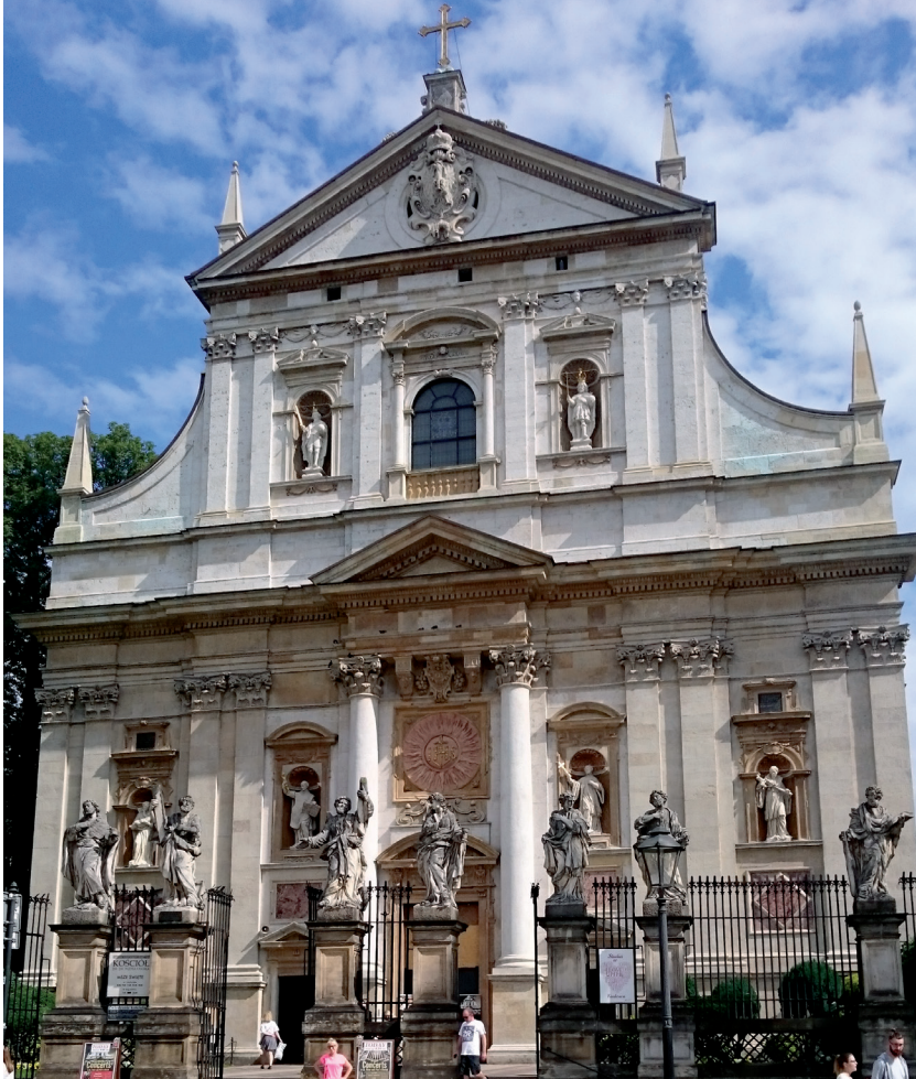
Fot. 4. Kościół pw. św. św. Piotra i Pawła po konserwacji elewacji.
