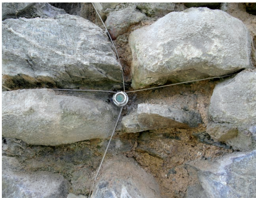
Kotwa stalowa osadzona w murze, widoczne linki stalowe.
