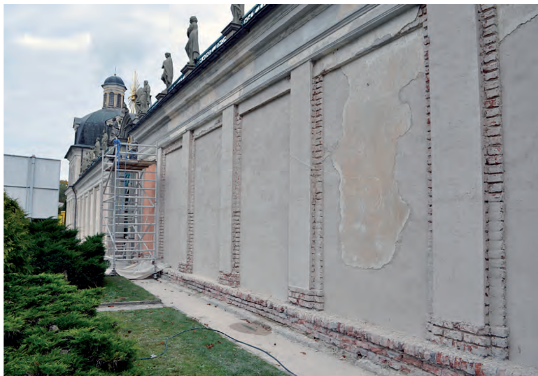
Widok fragmentu muru w Sanktuarium Maryjnym w Świętej Lipce, podczas wykonywania prac renowacyjnych z zastosowaniem zapraw bezcementowych Mape-Antique. .
