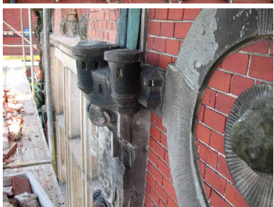
Politechnika Gdańska Detal elewacji – element w kształcie baszty zamkowej – zachowany oryginalny i nowy, zrekonstruowany w trakcie prac.
