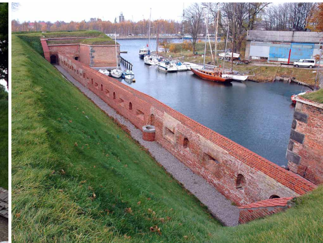
Twierdza Wisłoujście Mur kurtynowy przed i po pracach konserwatorskich i rekonstrukcyjnych.
