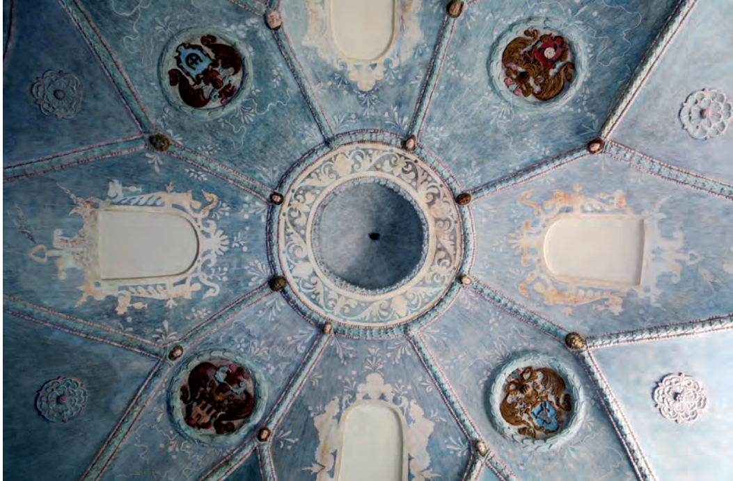
Sklepienie kaplicy pałacowej, stan po pracach konserwatorskich, 2015 r.
