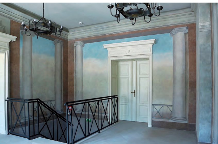
Pomieszczenie nr 2, foyer, parter pałacu, stan po pracach konserwatorskich z wyburzoną ścianą wtórną i nową aranżacją balustrady schodów do piwnicy, 2015 r.
