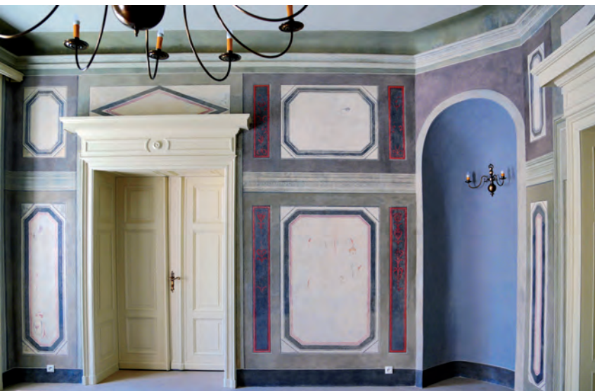
Pomieszczenie nr 3, parter pałacu, stan po pracach konserwatorskich, 2015 r.
