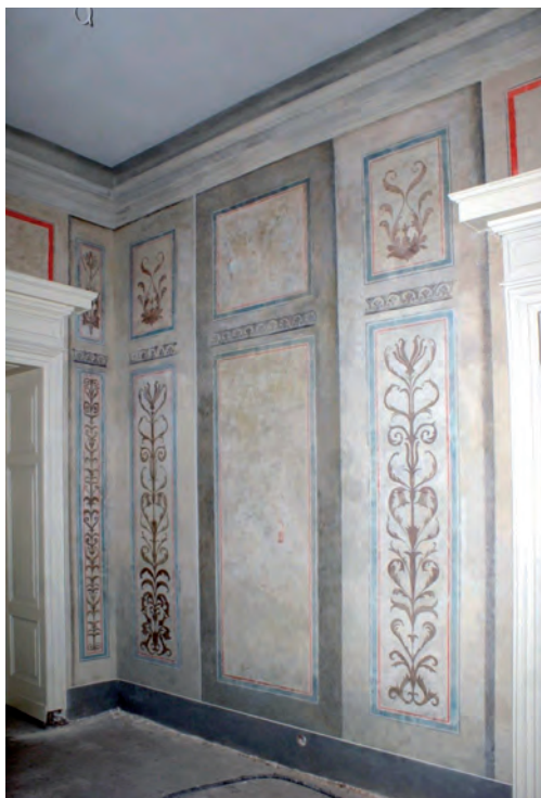
Pomieszczenie nr 1, parter pałacu, stan po pracach konserwatorskich, 2015 r.
