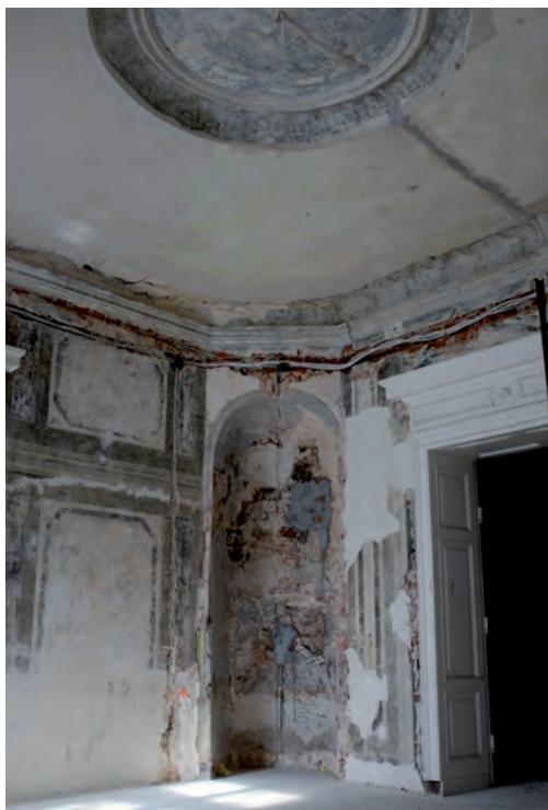
Pomieszczenie nr 3, parter pałacu, stan przed konserwacją, 2014 r.
