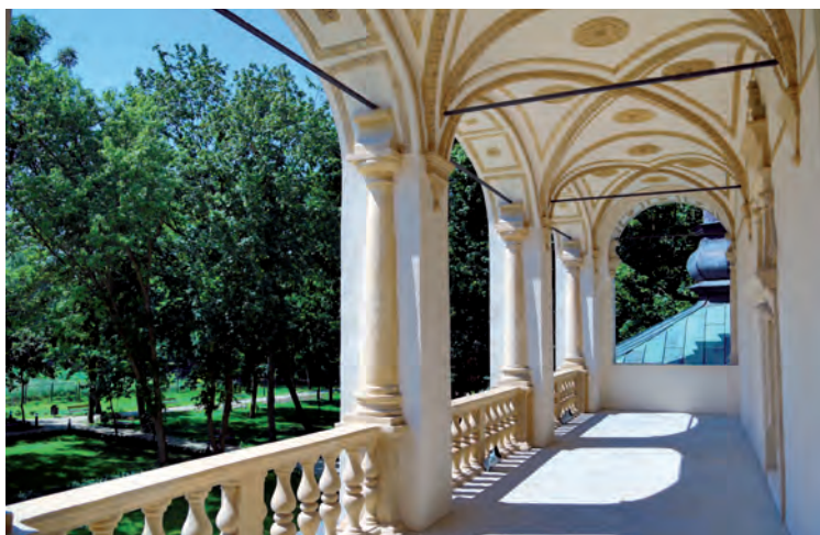
Loggia pałacowa ściany południowej, stan po pracach konserwatorskich, 2015 r.
