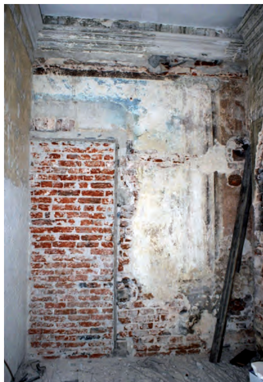
Pomieszczenie nr 2, foyer, parter pałacu, stan przed konserwacją, 2014 r.
