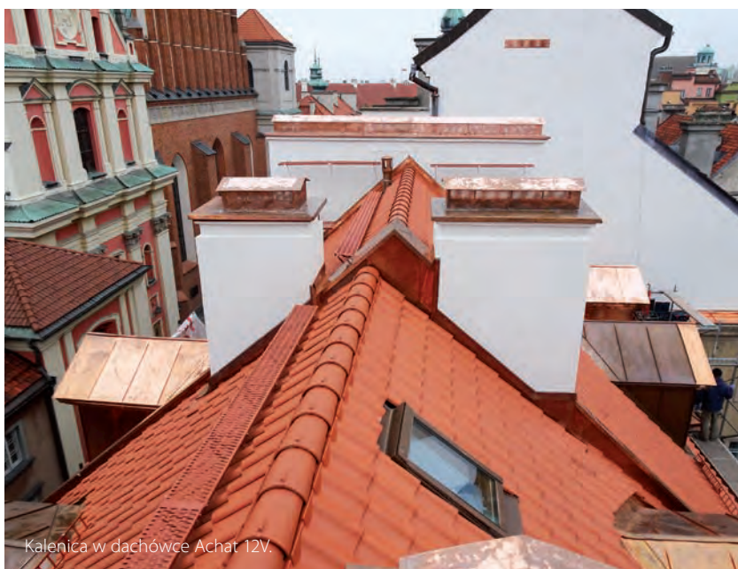
Prace na kalenicy.
