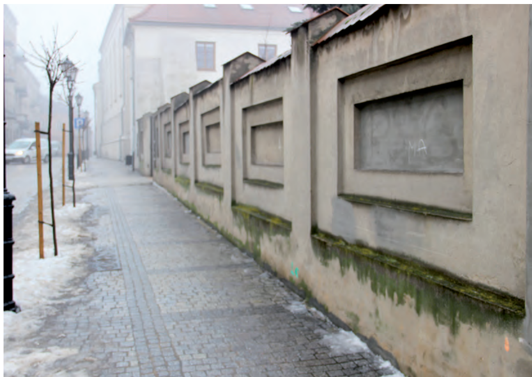
Parkan przy ul. Rycerskiej, z widocznym w złym stanie technicznym zwieńczeniu muru, stan przed remontem.
