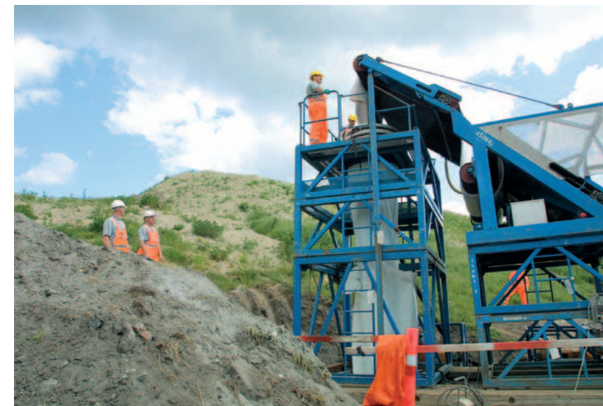
Instalacja rękawa AARSLEFF przy zastosowaniu wody z wykorzystaniem wieży inwersyjnej.
