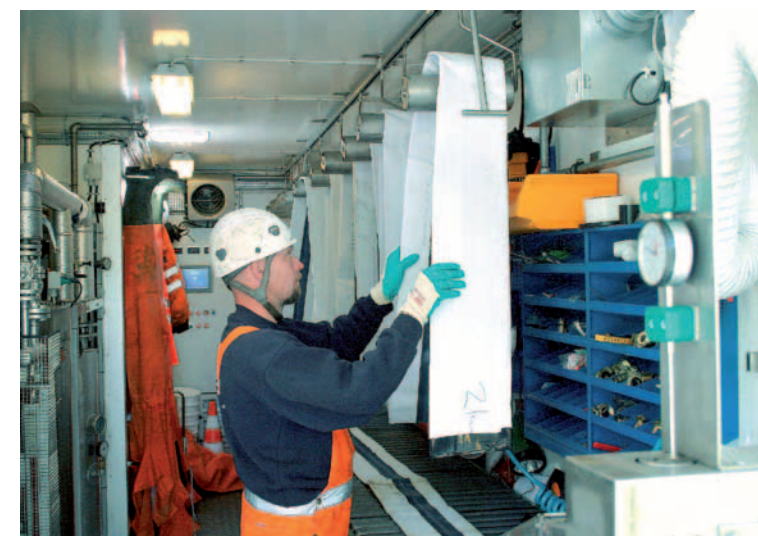
Przygotowanie długich profili kapeluszowych do nasączania i instalacji.
