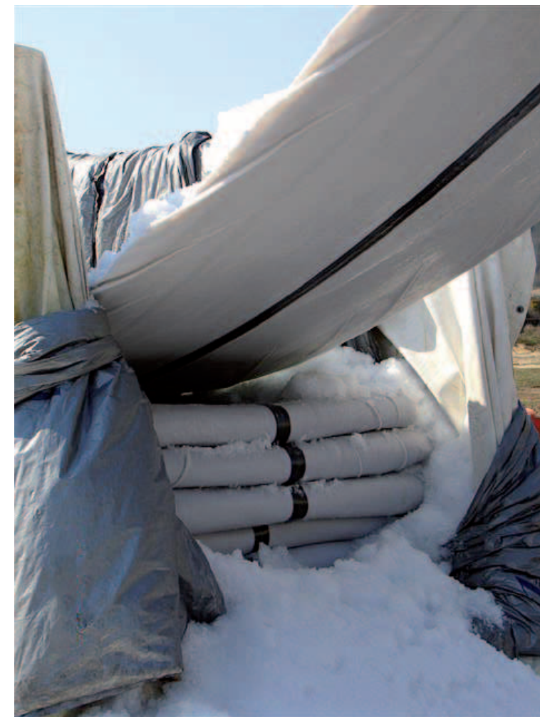
Zaimpregnowany rękaw transportowany w lodzie.
