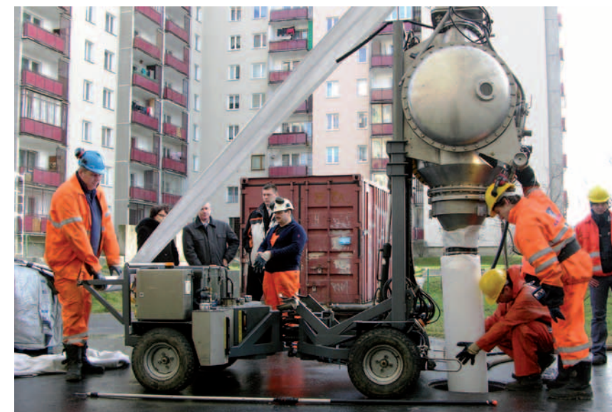
Instalacja rękawa AARSLEFF przy zastosowaniu sprężonego powietrza z wykorzystaniem robota inwersyjnego.
