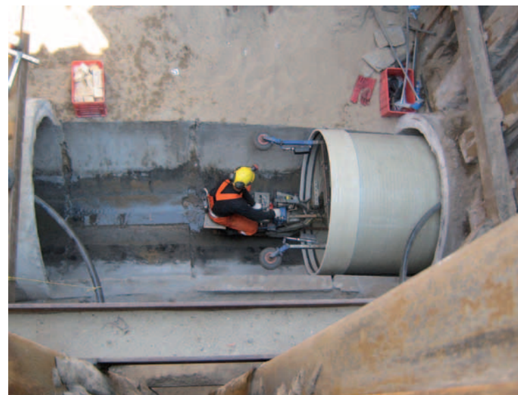
Wprowadzenie z wykopu startowego paneli GRP za pomocą wózka.
