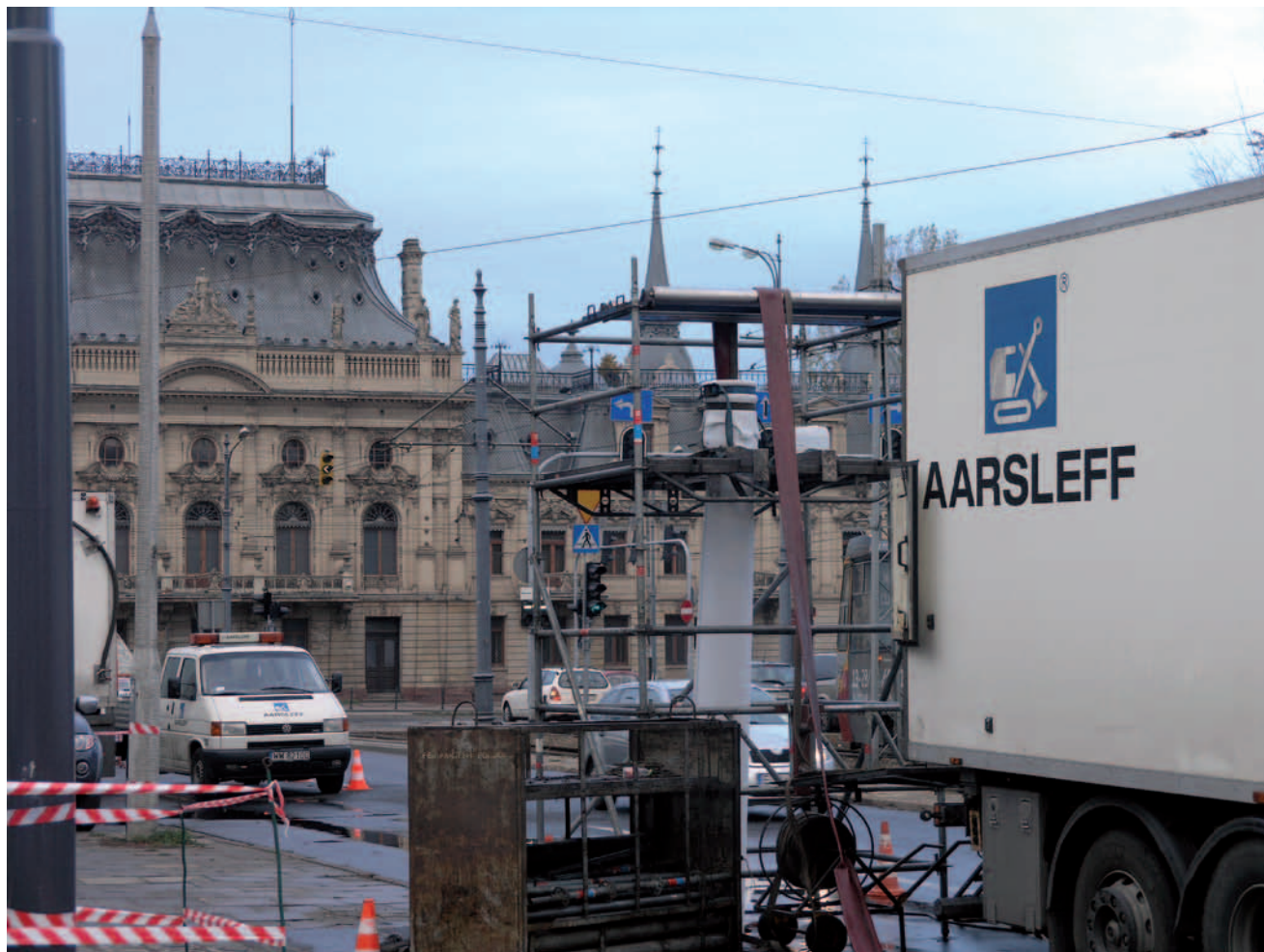
Łódź, ul. Ogrodowa – w tle Pałac Poznański – renowacja kanalizacji w technologii rękawa AARSLEFF.
