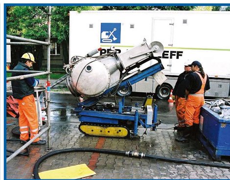
Kraków, instalacja rękawa robotem inwersyjnym
