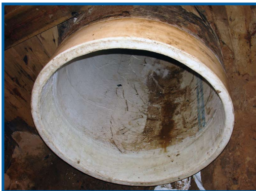
Zainstalowany rękaw
