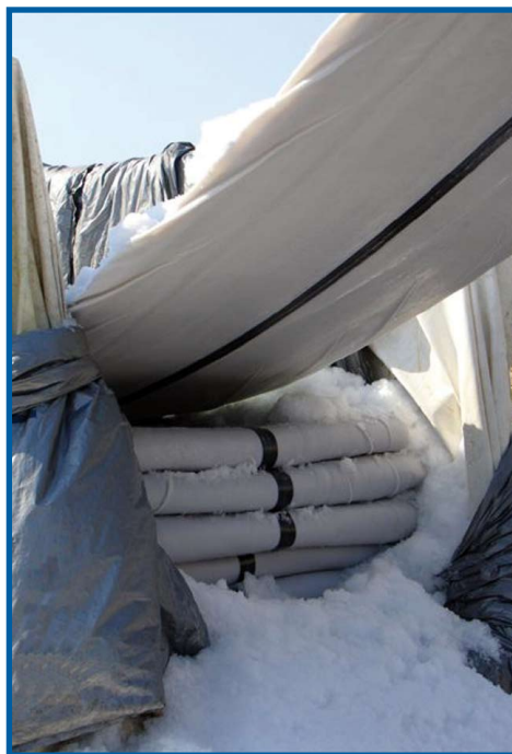
Zaimpregnowany rękaw transportowany w lodzie.
