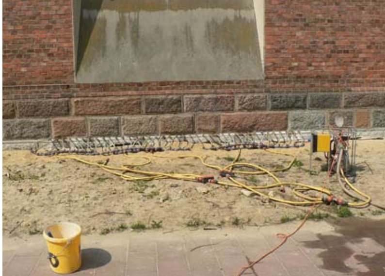
Bazylika Sanktuarium Matki Bożej Kębskiej w Wąwolnicy. Metoda StoMurisol-Impulssystem umożliwia wprowadzenie preparatu w 64 otwory jednocześnie, co przyspiesza pracę.
