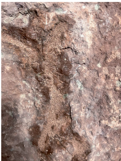
Iniekcja zawiesziną sporządzoną z KSE 500 STE oraz systemowych wypełniaczy mineralnych A i B (fot. po lewej)
