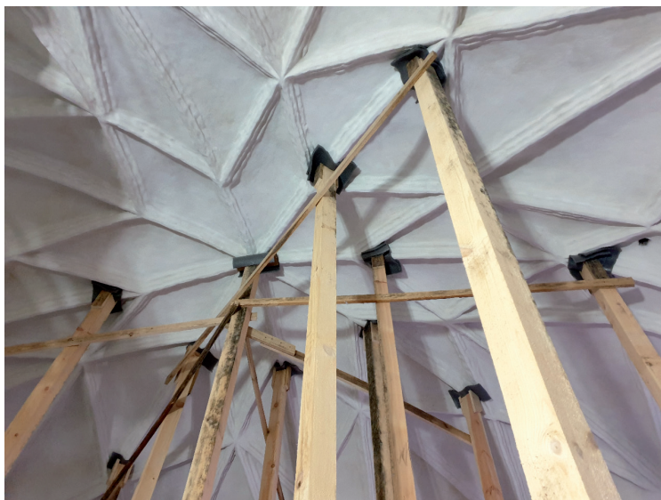
Rys. 2. Zabezpieczenie sklepienia w trakcie prowadzenia prac naprawczych
