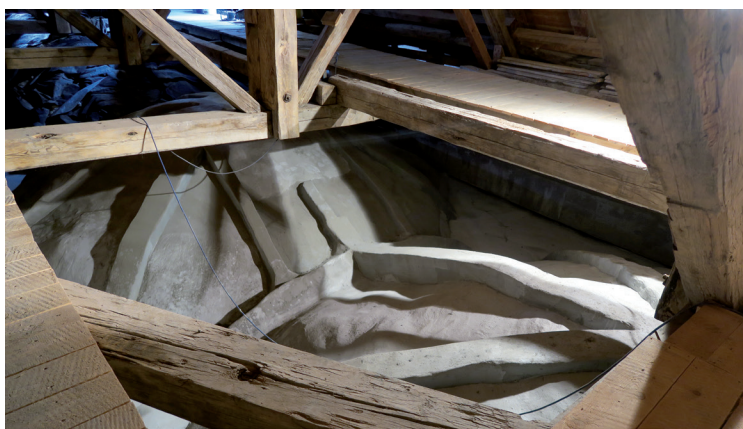
Rys. 3. Widok sklepienia po wykonaniu wzmocnień siatką z włókna węglowego
