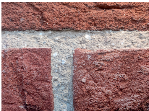
Fot. 3. Dwie różne mieszanki składu zaprawy spoinującej na bazie Remmers Historic Kalkspatzenmörtel
