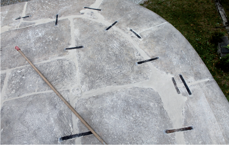
Fot. 5. Nowe spoiny z zaprawy Remmers FM ECC
